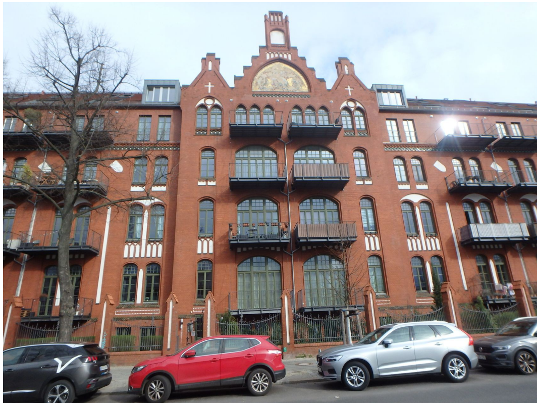
Wohnhausblock (Aufgang Sophie-Charlotten-Straße 115) Westansicht (Straßenansicht Sophie-Charlotten-Straße)
