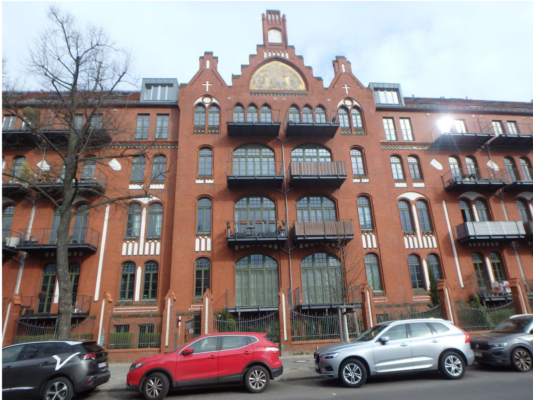
Wohnhausblock (Aufgang Sophie-Charlotten-Straße 115) Westansicht (Straßenansicht Sophie-Charlotten-Straße)
