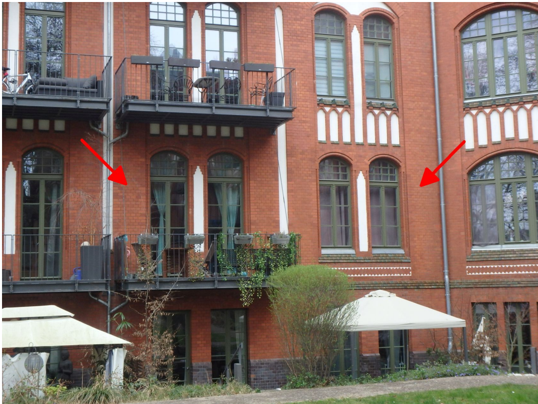
Wohnhausblock sowie Eigentumseinheit Nr. B.1.1 Ostansicht
