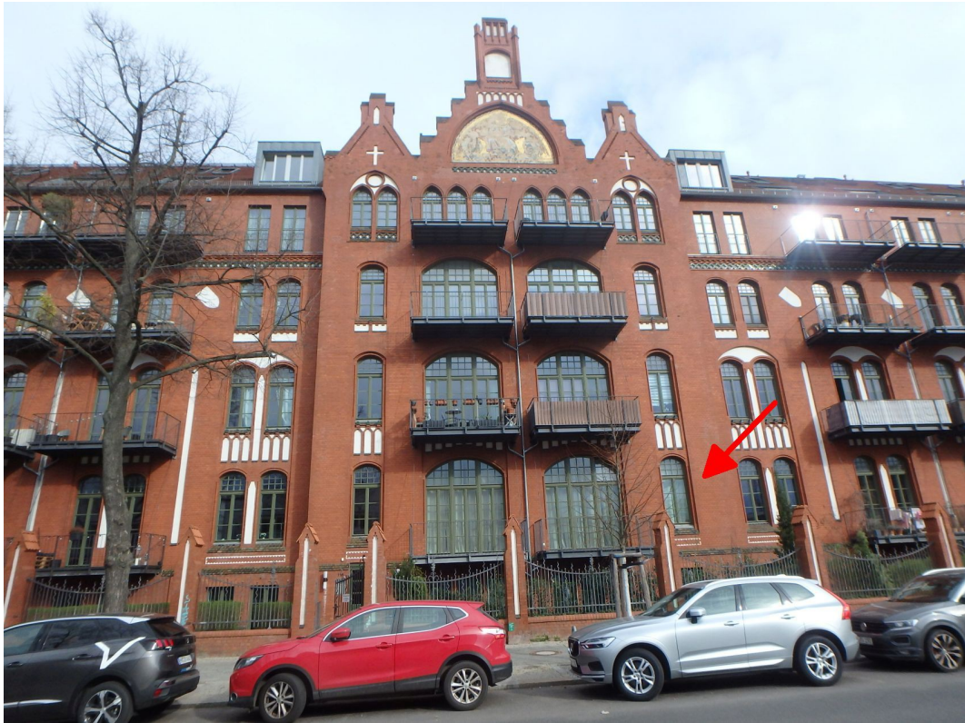
Wohnhausblock (Aufgang Sophie-Charlotten-Straße 115) Westansicht (Straßenansicht Sophie-Charlotten-Straße)
