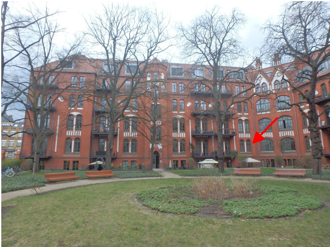
Wohnhausblock Ostansicht (Gartenansicht)
