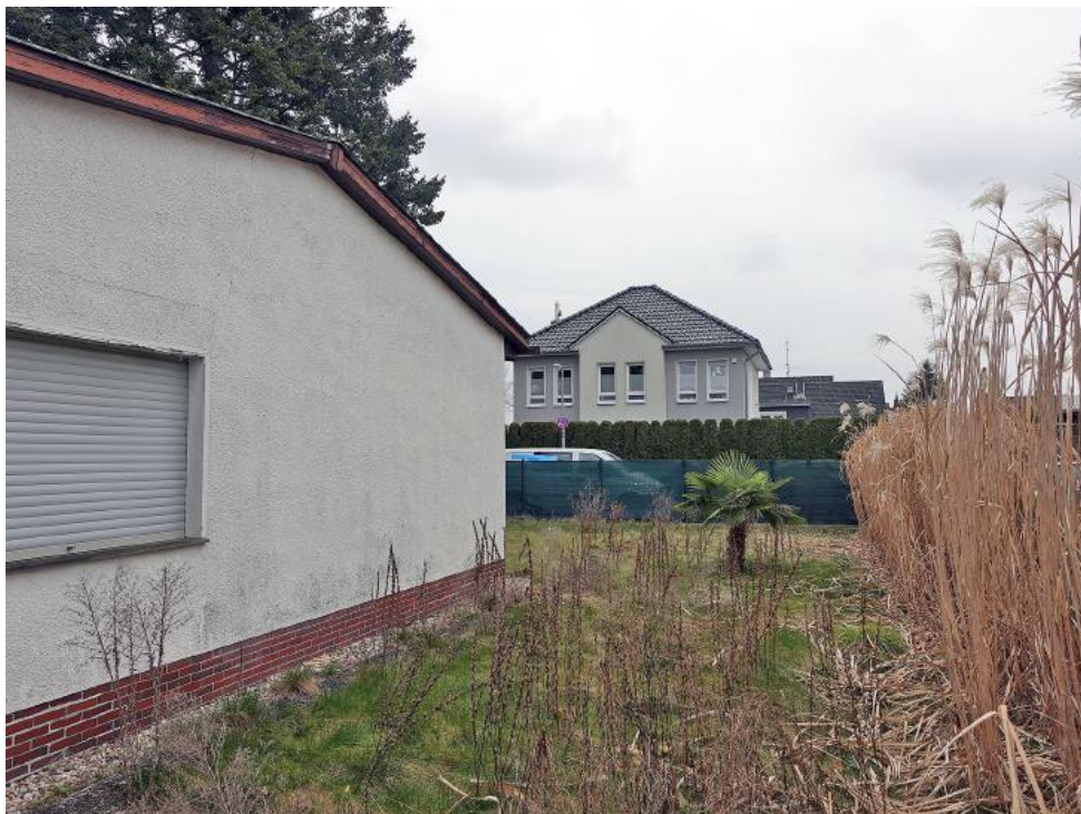
Süd-West-Fassade, Blick zur Straße
