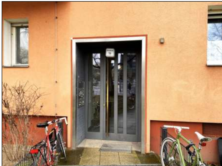
Hauseingangstür des auf dem Grundstück Franklinstraße 16 aufstehenden Gebäudekomplexes in der nach Nord-Osten orientierten Hauseingangsfront
