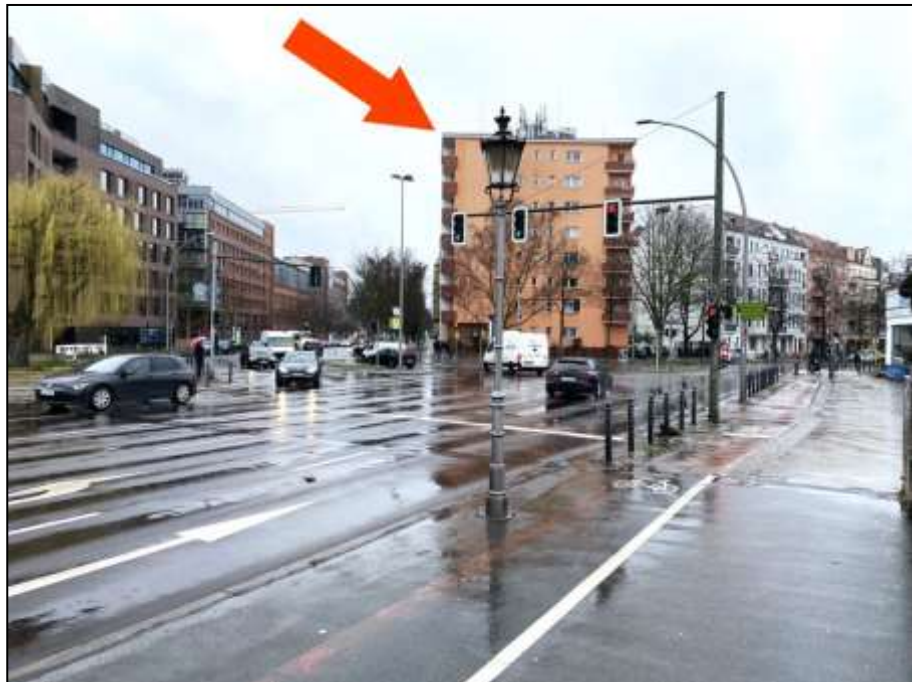
Blick von der Gotzkowskybrücke nach Süd-Westen mit Lage des auf dem Grundstück Franklinstr. 16 aufstehenden Wohngebäudes (Pfeil) zwischen der Franklinstraße links und der Helmholzstraße rechts im Bild
