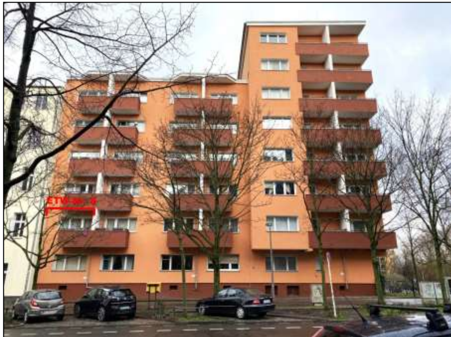
zur Franklinstraße orientierte Front des 6- und 8-geschossigen Gebäudekomplexes auf dem Grundstück Franklinstraße 16 mit Lage des Wohnungseigentums Nr. 8 im 1.OG des 6-geschossigen Gebäudeteils
