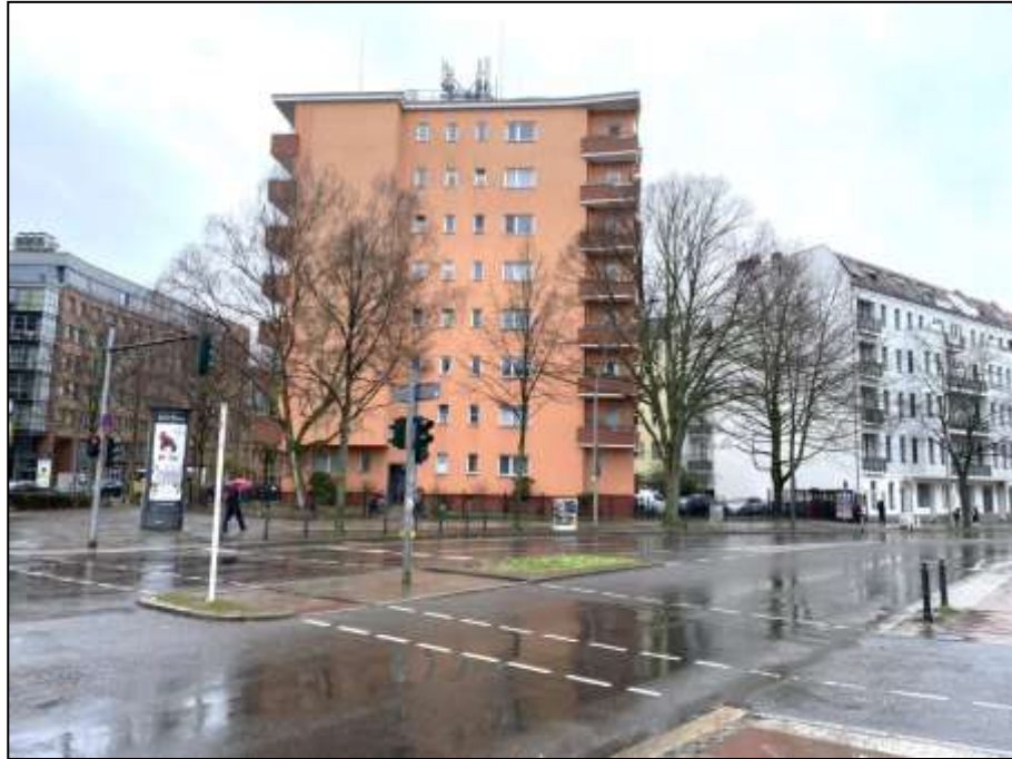
Blick von der Gotzkowskybrücke nach Süd-Westen mit Hauseingangsfront des auf dem Grundstück Franklinstr. 16 aufstehenden Wohngebäudes zwischen der Franklinstraße links und der Helmholzstraße rechts im Bild
