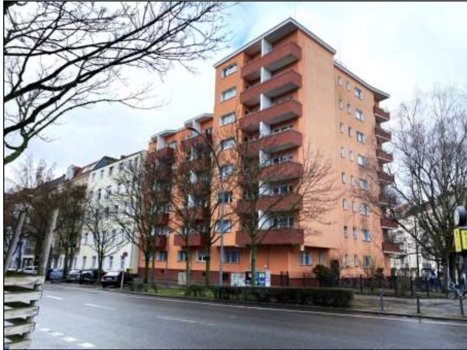
zur Franklinstraße orientierte Front des 6- und 8-geschossigen Gebäudekomplexes auf dem Grundstück Franklinstraße 16
