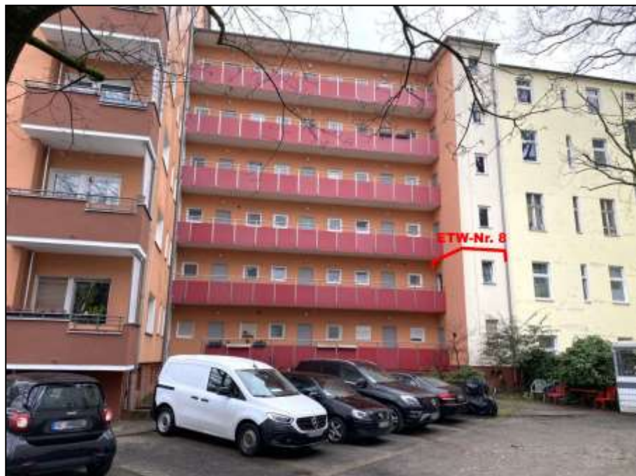
Blick aus der Helmholzstraße nach Süd-Osten auf das auf dem Grundstück Franklinstr. 16 aufstehende Wohngebäude mit 6-geschossigem Laubengangtrakt u.a. mit Lage des Wohnungseigentums Nr. 8 im 1.OG
