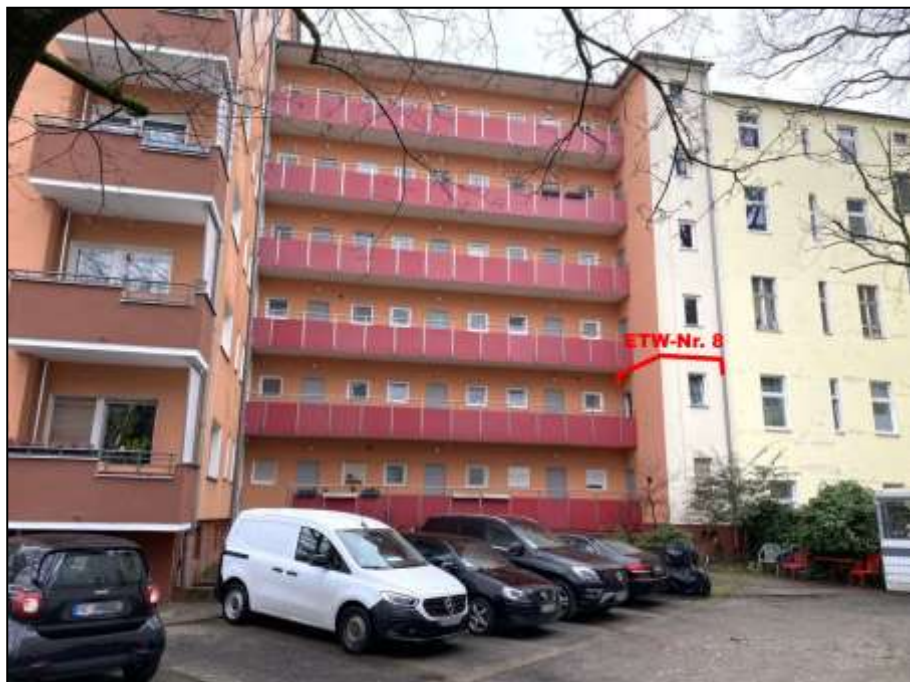
Blick aus der Helmholtzstraße nach Süd-Osten auf das auf dem Grundstück Franklinstr. 16 aufstehende Wohngebäude mit 6-geschossem Laubengangtrakt u.a. mit Lage des Wohnungseigentums Nr. 8 im 1.OG
