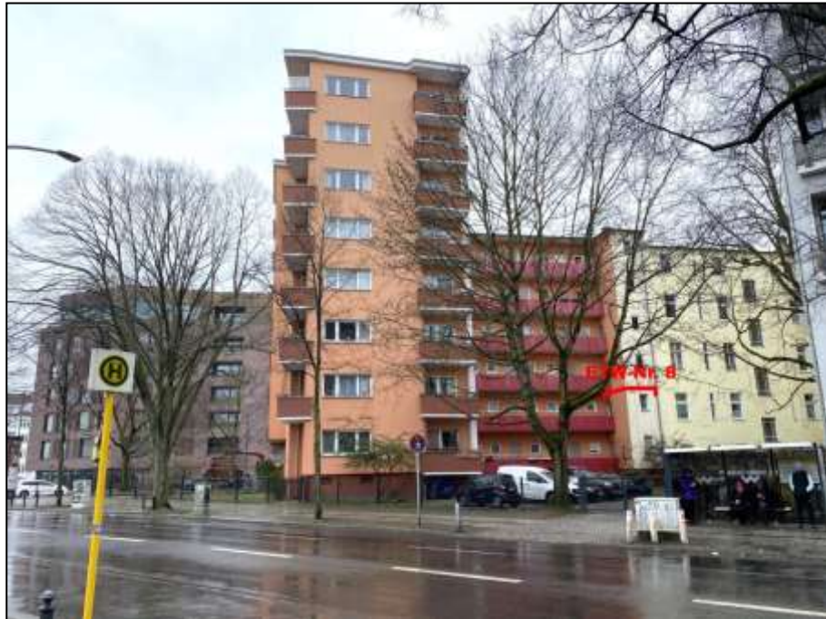
Blick über die Helmholtzstraße nach Süd-Osten auf das auf dem Grundstück Franklinstr. 16 aufstehende Wohngebäude mit 8-geschossem Gebäudeteil links und 6-geschossem Laubengangtrakt rechts im Bild u.a. mit Lage des Wohnungseigentums Nr. 8 im 1.OG
