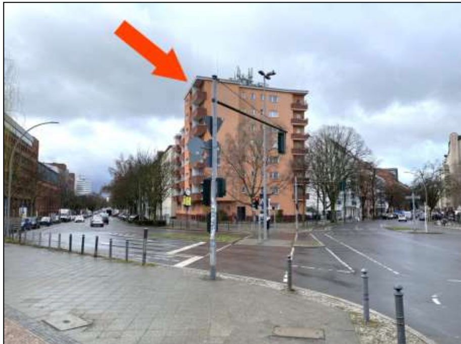
Blick von der Gotzkowskybrücke nach Süd-Westen mit auf dem Grundstück Franklinstr. 16 aufstehendem Wohngebäude zwischen der Franklinstraße links und der Helmholzstraße rechts im Bild (Pfeil)
