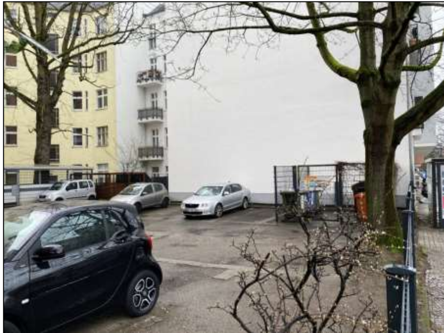
Blick aus der Helmholzstraße nach Süd-Westen in den Hof des Grundstücks Franklinstr. 16 mit PKW-Stellplatzanlage und Müllgefäßstellplatz sowie gedecktem bzw. eingehaustem Fahrradabstellplatz links im Bild
