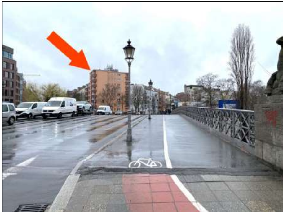
Blick über die Gotzkowskybrücke nach Süd-Westen mit Lage des auf dem Grundstück Franklinstr. 16 aufstehenden Wohngebäudes (Pfeil)
