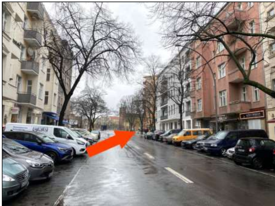
Blick in die Helmholzstraße nach Nord-Osten mit Lage des Grundstücks Franklinstraße 16 auf der südlichen bzw. im Bild rechten Straßenseite (Pfeil)
