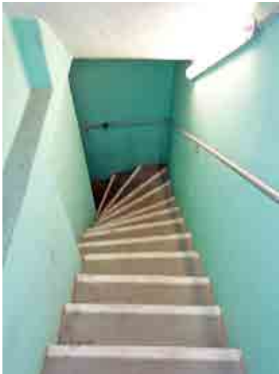
Kellerzugang, Ausgang Waßmannsdorfer Chaussee
