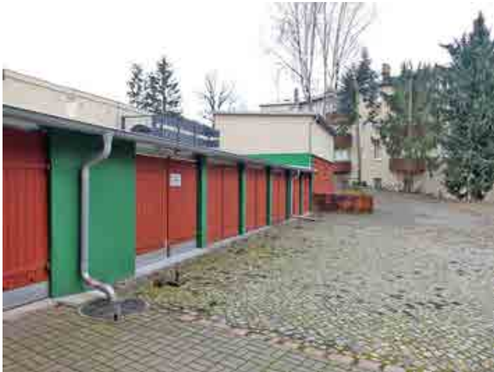
Garagenzeile im Hof, Blick zur Zufahrt
