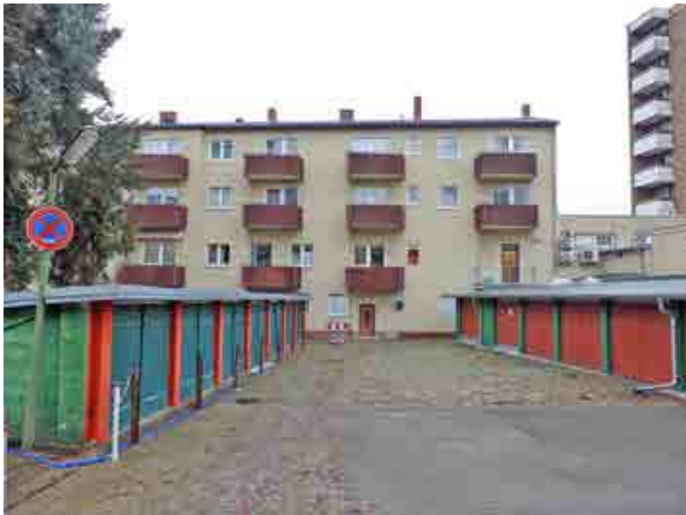
Garagenzeile im Hof, Blick auf die Hoffassaden der Häuser Neuköllner Straße 348, 350
