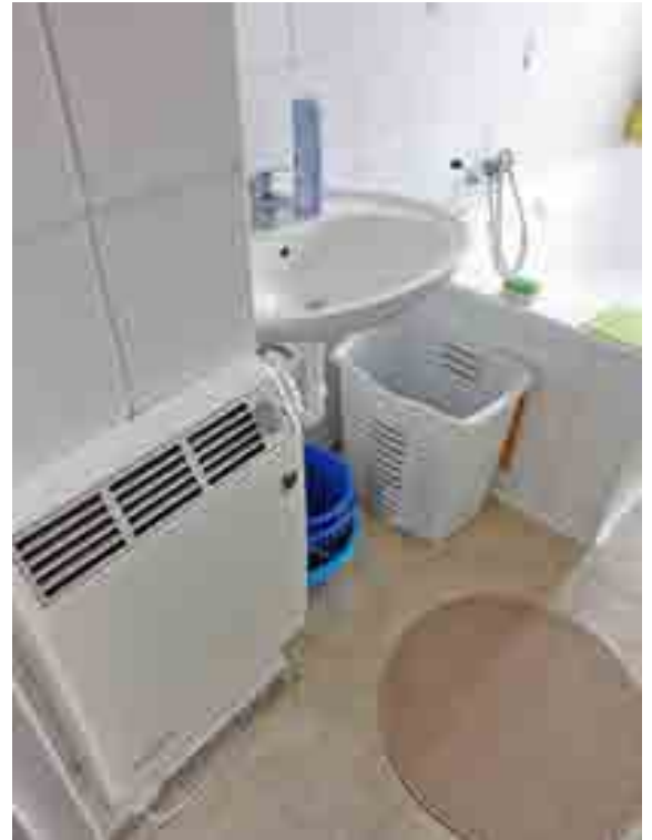
Bad mit Nachtspeicherheizung
