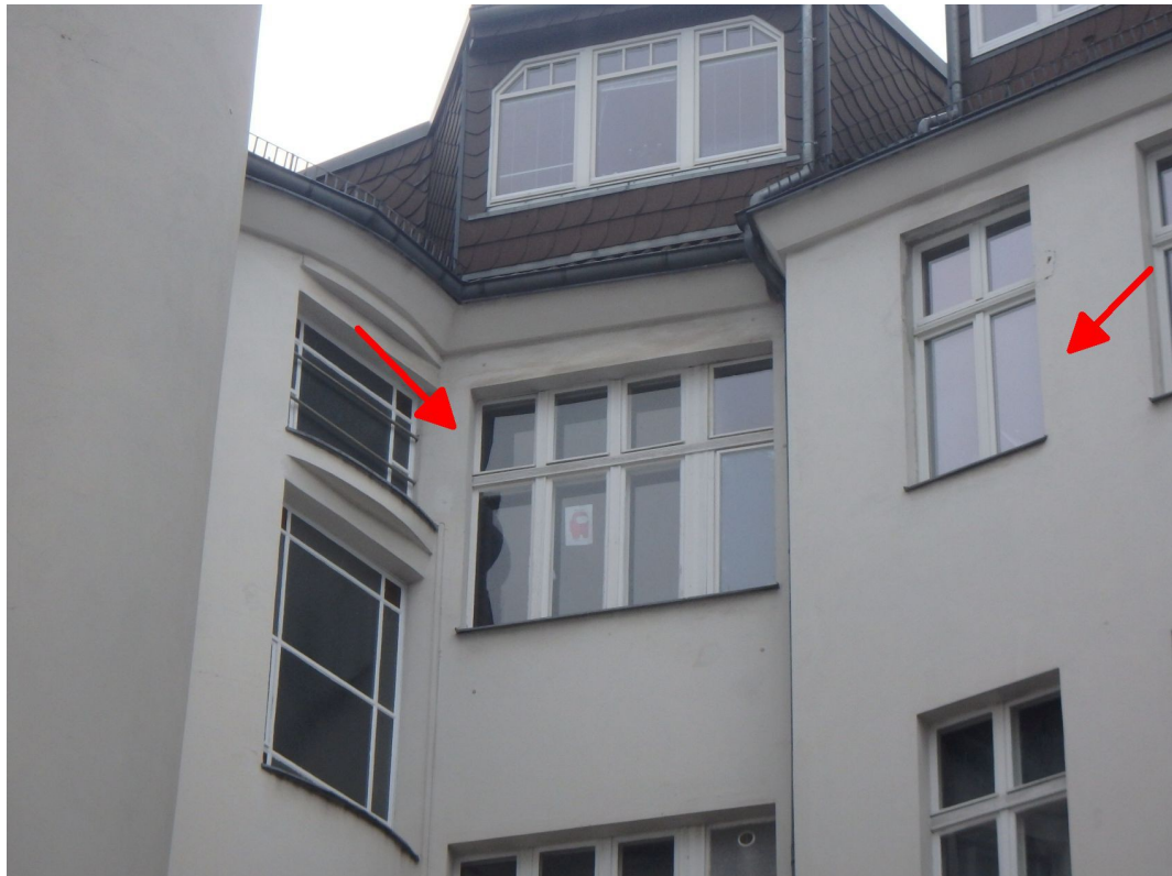
Vorderwohn- und Geschäftshaus mit Seitenflügel sowie Eigentumseinheit Nr. 12 Nordostansicht
