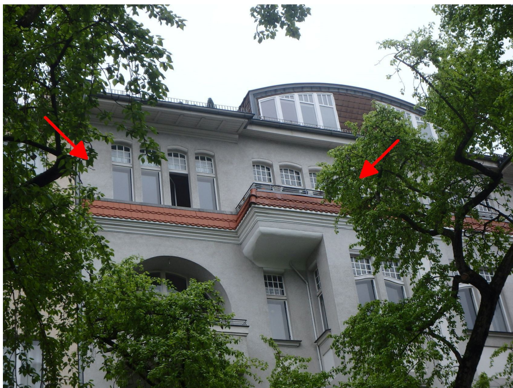
Vorderwohn- und Geschäftshaus sowie Eigentumseinheit Nr. 12 Südansicht
