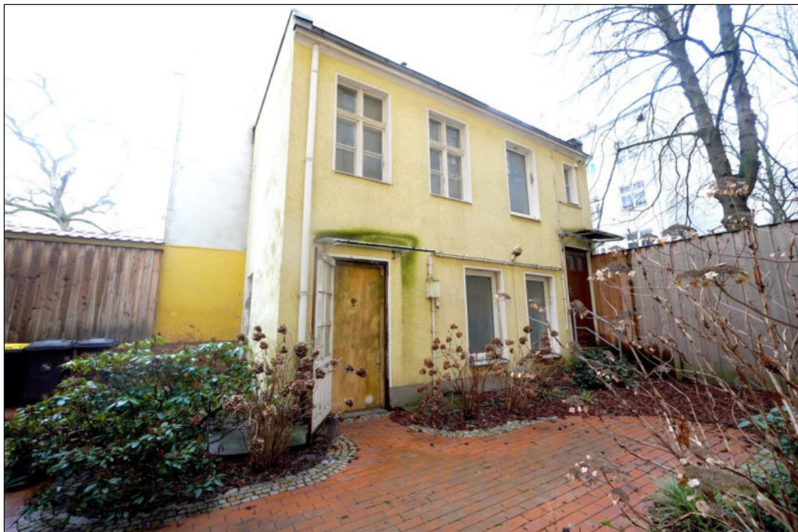
Remise im Hof
