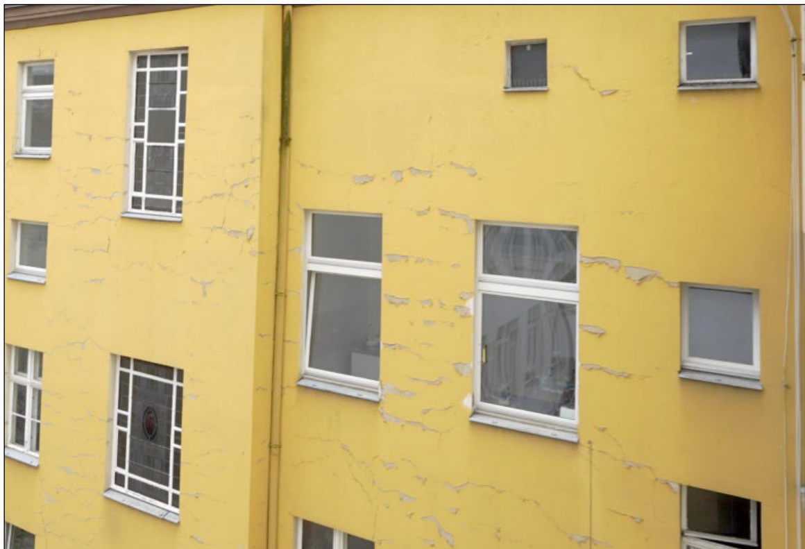
Farbschäden Fassade
