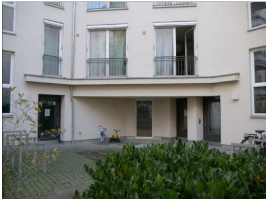
Hofbereich unmittelbar hinter dem Zwickel der beiden zur Dahmannstraße (rechts) und zur Sybelstraße (links) orientierten Gebäudeschenkel mit jeweiligem Treppenhauseingang und davor belegenem unterirdischem Teil der Tiefgarage
