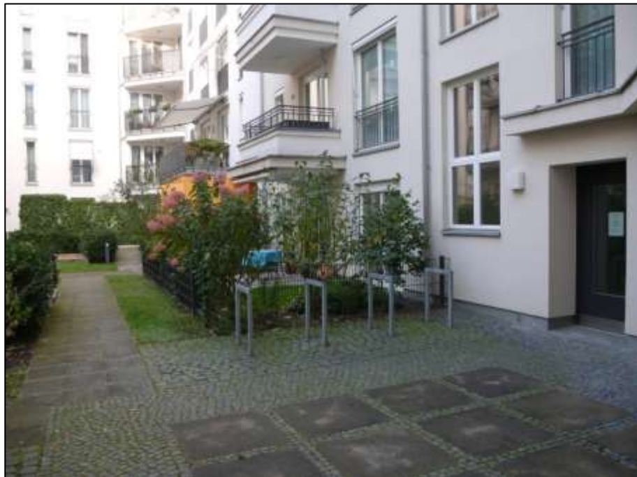
Hofbereich unmittelbar hinter dem zur Sybelstraße orientierten Gebäudeschenkel mit darunter belegenem unterirdischem Teil der Tiefgarage und Zuwegung zur Feuerwehrdurchfahrt auf dem angrenzenden Nachbargrundstück Sybelstr. 49 (Flurstück 4474/208 u.a.)
