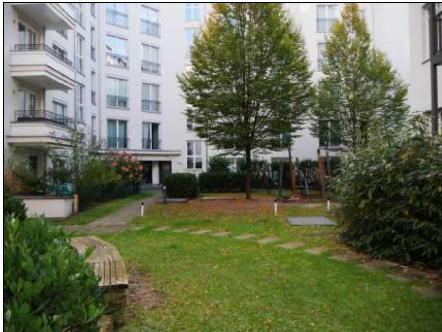
Blick aus dem Hof des angrenzenden Nachbargrundstücks Sybelstr. 49 (Flurstück 4474/208 u.a.) in den Hof des auf dem Eckgrundstück Dahmannstr. 8, Sybelstr. 50 belegenen Gebäudekomplexes
