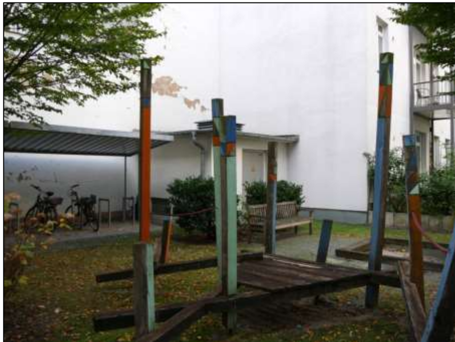
Hof des auf dem Eckgrundstück Dahlmannstr. 8, Sybelstr. 50 belegenen Gebäudekomplexes mit Spielplatz, gedecktem Fahrradunterstand und Netzstation (im Hintergrund)
