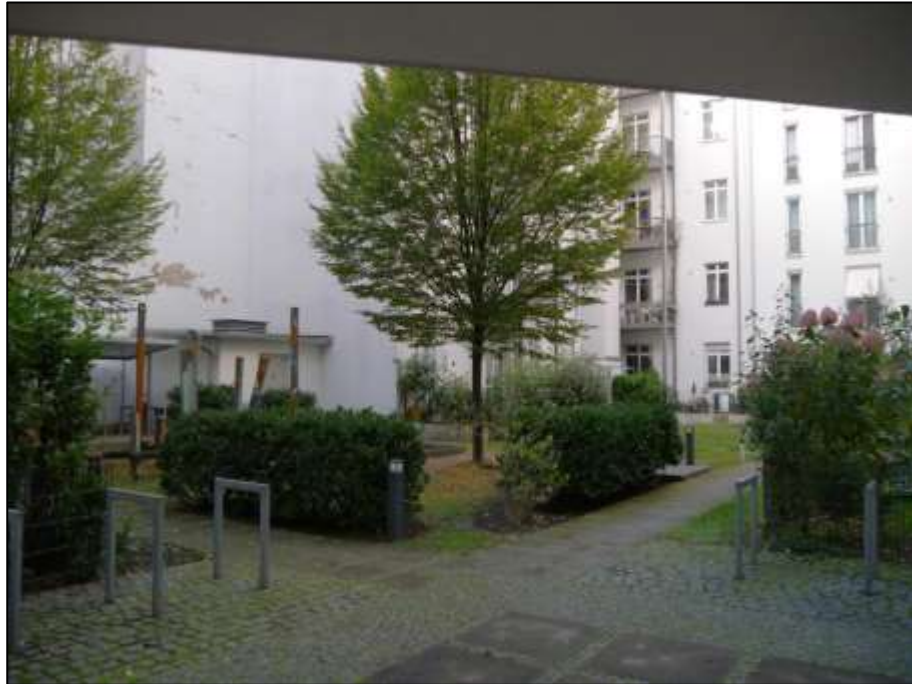
Hofbereich unmittelbar hinter dem Zwickel der beiden zur Dahmannstraße und zur Sybelstraße orientierten Gebäudeschenkel mit davor belegenem unterirdischem Teil der Tiefgarage sowie Spielplatz und Netzstation im Hintergrund links sowie aufstehende Wohnhausbebauung auf dem Nachbargrundstück Sybelstr. 49 (Flurstück 4474/208 u.a.) im Hintergrund rechts
