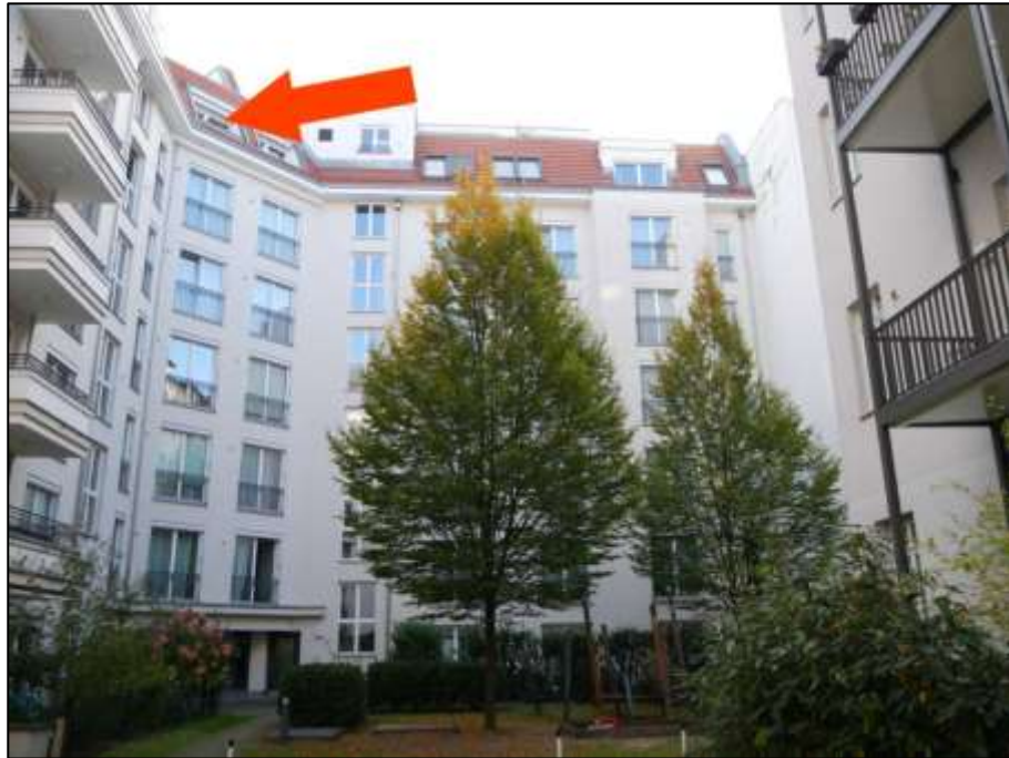
Blick aus dem Hof des angrenzenden Nachbargrundstücks Sybelstr. 49 (Flurstück 4474/208 u.a.) auf die hofseitige Front des auf dem Eckgrundstück Dahmannstr. 8, Sybelstr. 50 belegenen Gebäudekomplexes mit Lage des ETW-Nr. 31 im Dachgeschoss des Gebäudeteils Sybelstr. 50 (Pfeil)
