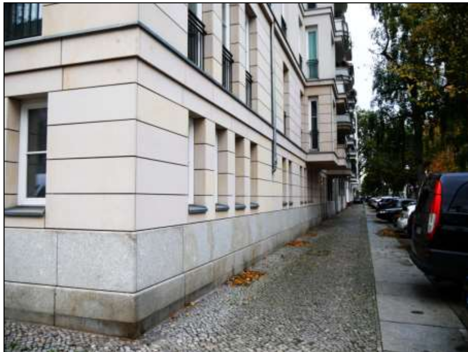
Sockelbereich der zur Sybelstraße orientierten Gebäudefront mit davor belegtem Fußweg im Straßenraum
