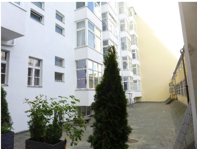
Hofseitige Gebäudeansicht Mehrfamilienhaus (15.05.2025)
