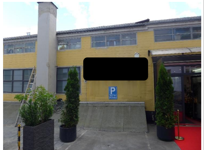
Hofseitige Gebäudeansicht Gewerbegebäude (15.05.2025)
