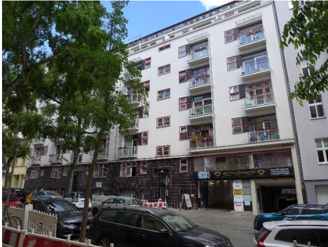
Straßenseitige Gebäudeansicht Mehrfamilienhaus (15.05.2025)
