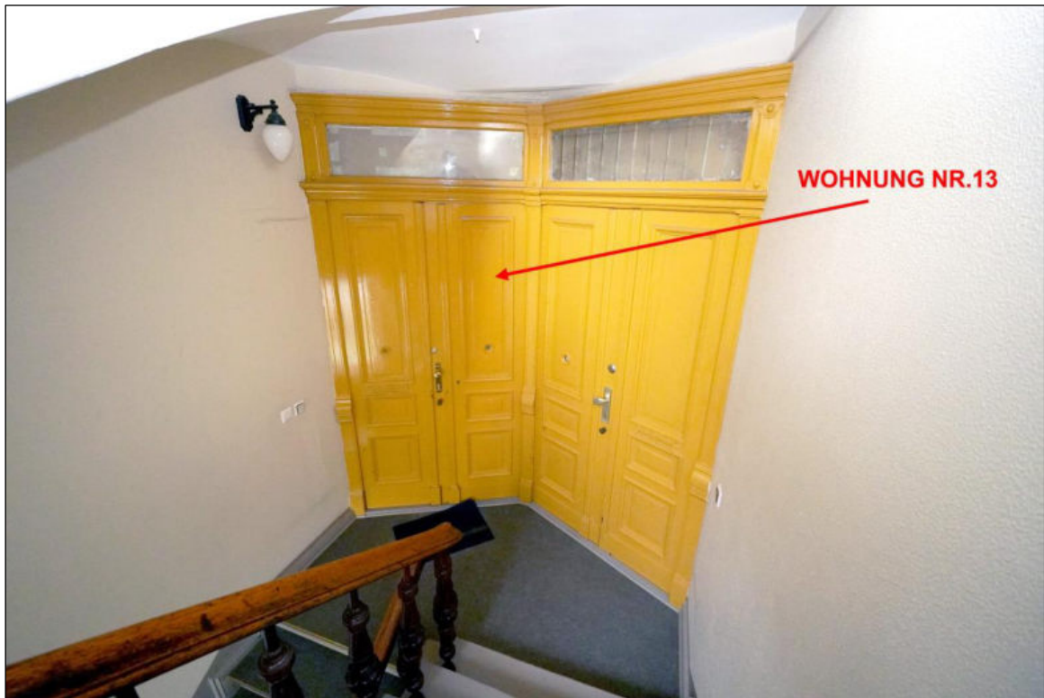
Wohnungseingangstüren im Vorderhaus
