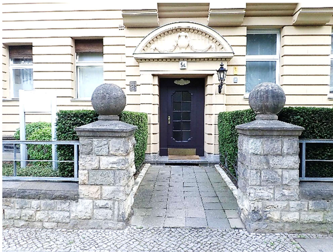
Hauseingang „Franzensbader Straße 5A“ zur Straßenseite
