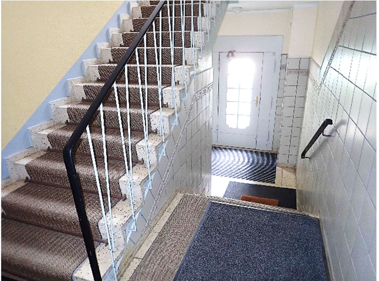
Hauseingang-Innenansicht „Franzensbader Straße 5A“
