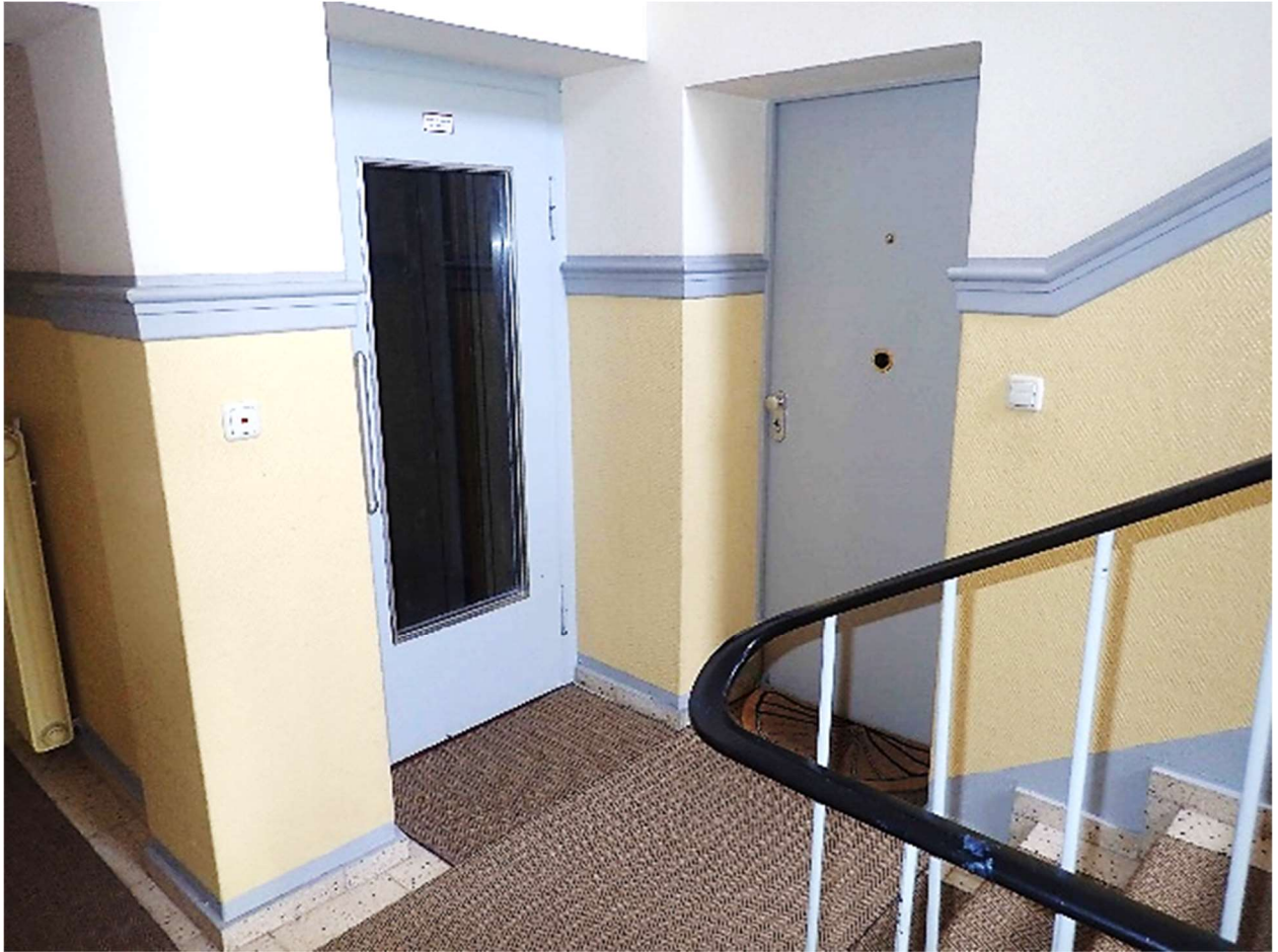
Wohnungseingangstür Wohnung Nr. 7 rechts, links Aufzugstür
