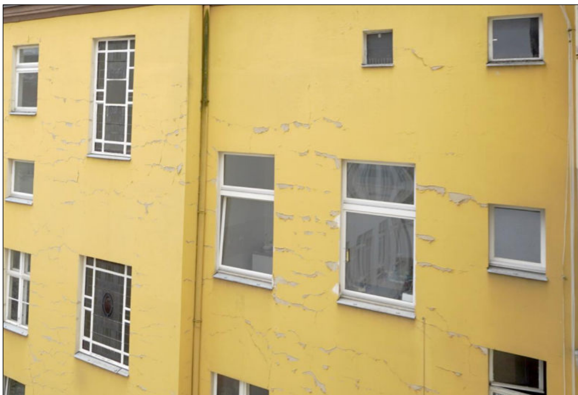
Farbschäden Fassade
