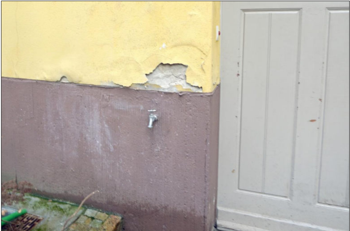
Putzschäden Sockel
