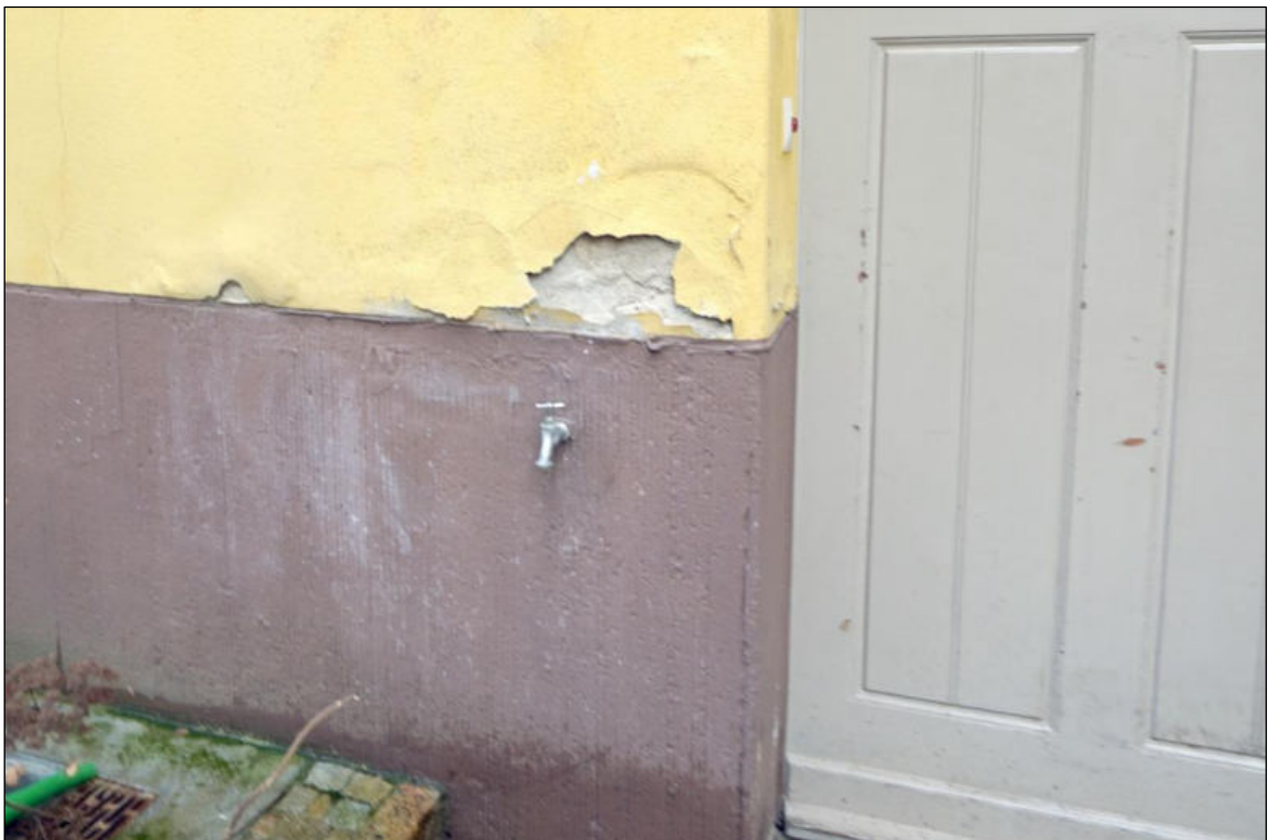
Putzschäden Sockel
