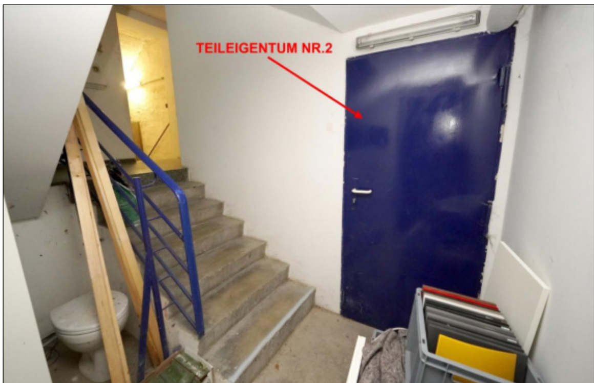
Eingangstür im Kellergeschoss
