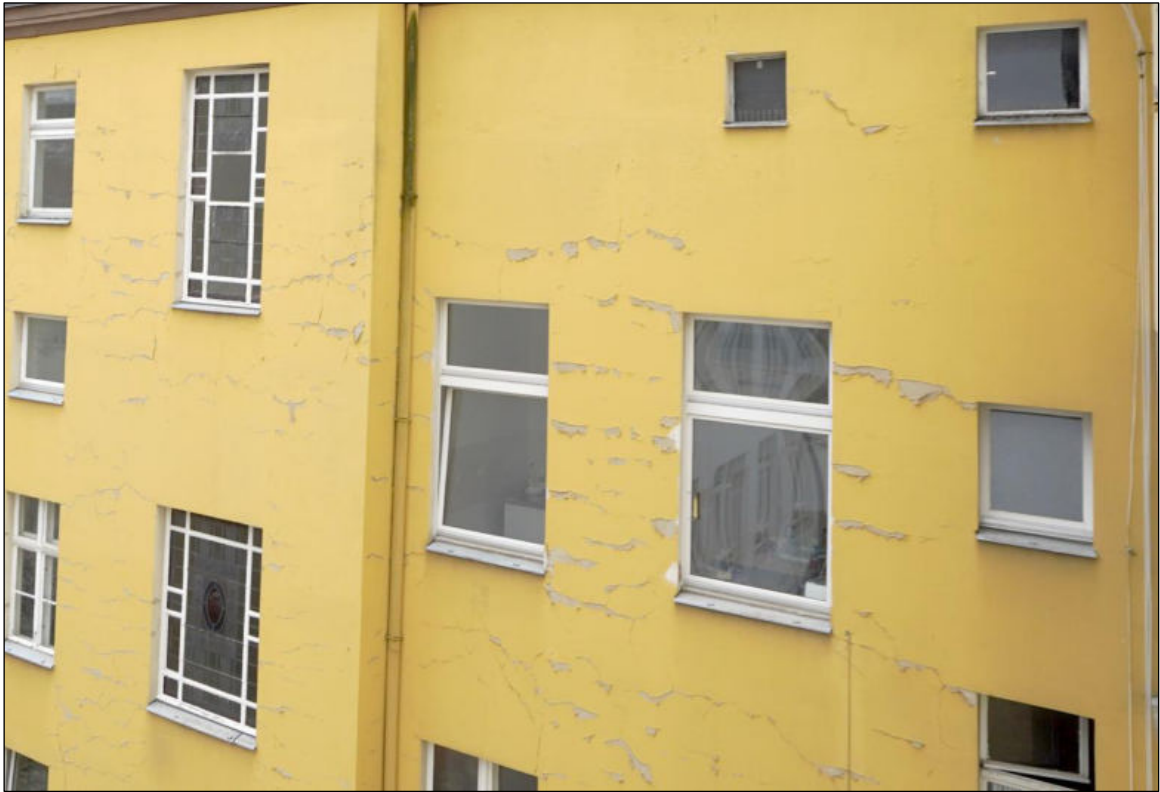
Farbschäden Fassade
