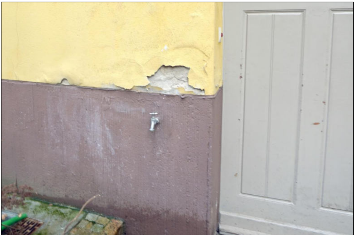
Putzschäden Sockel
