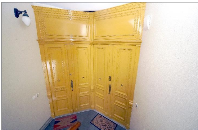
Wohnungseingangstüren im Vorderhaus
