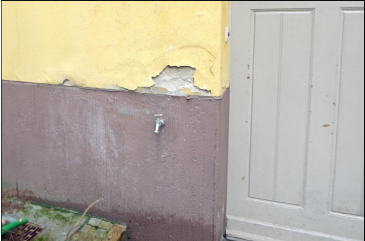
Putzschäden Sockel
