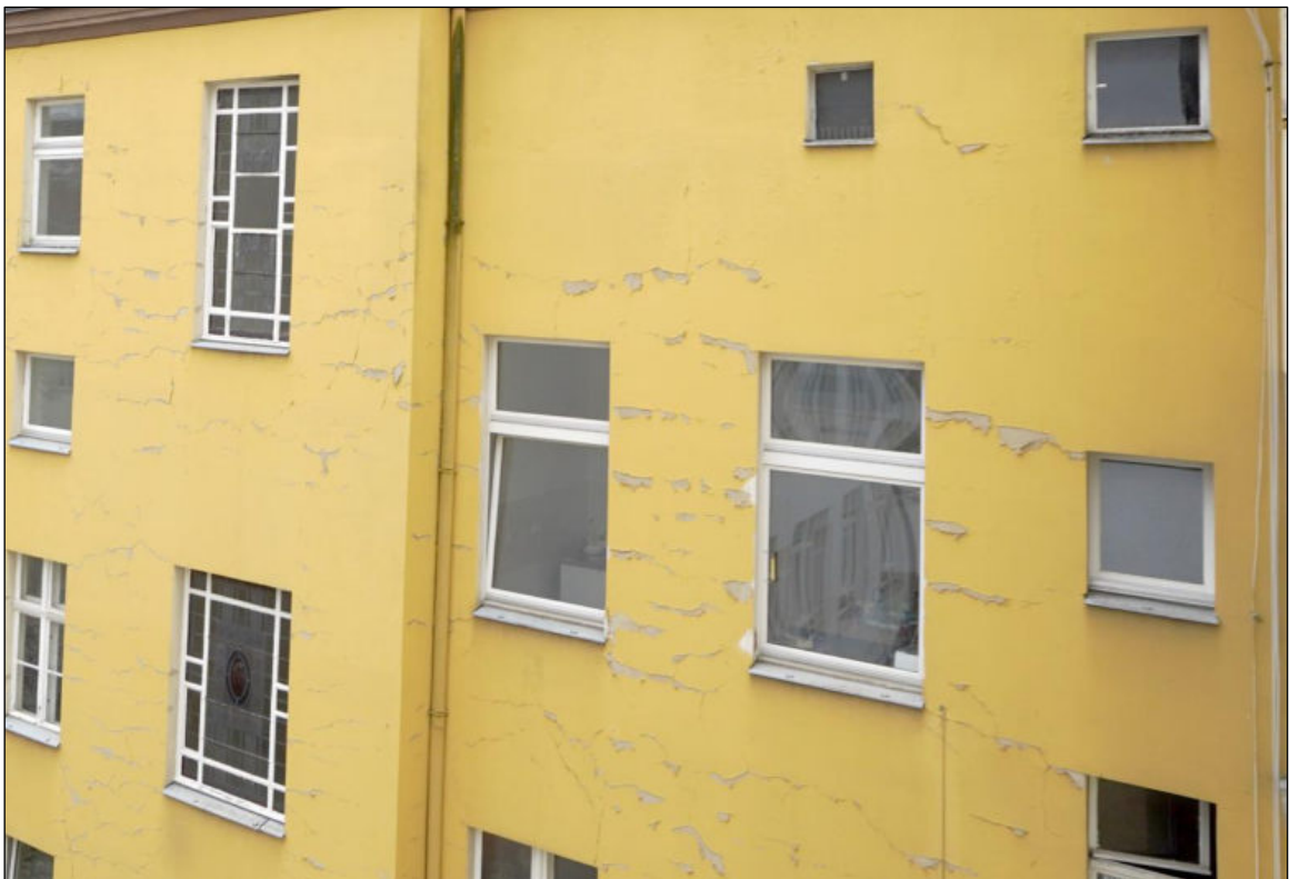
Farbschäden Fassade
