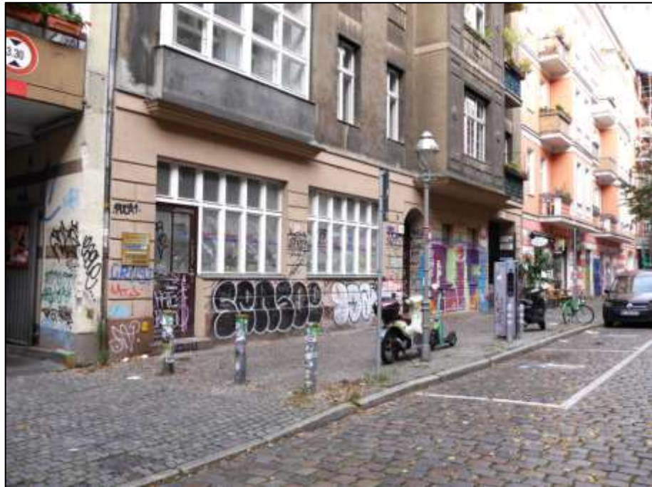
straßenseitige Front des Vorderhauses im Bereich des Erdgeschosses und Wallbox-Parkstände unmittelbar vor dem Grundstück
