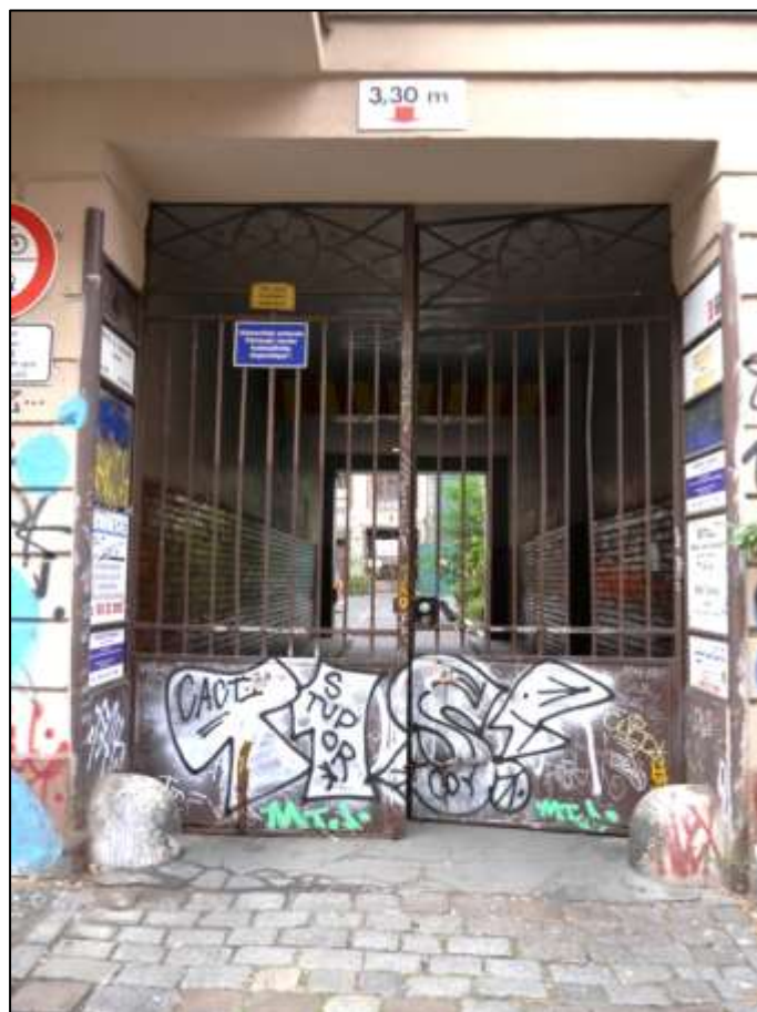
Gebäudedurchfahrt im Vorderhaus zu dem rückwärtig auf dem Grundstück belegenen Hof
