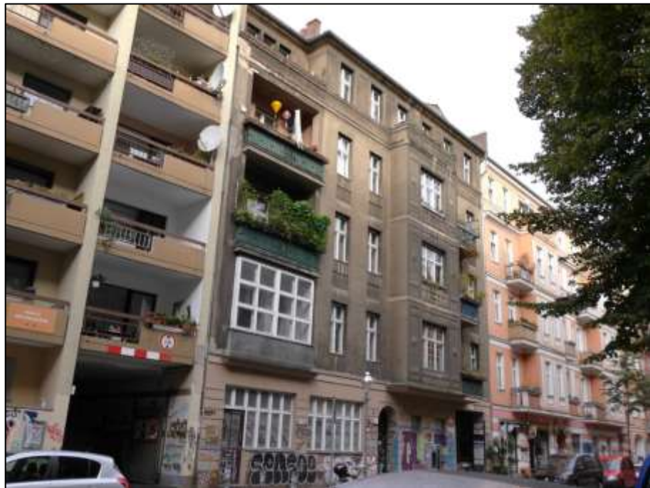
straßenseitige Front des Vorderhauses
