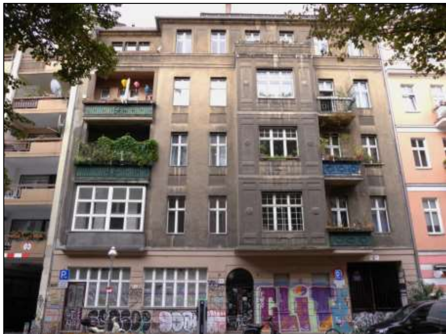
straßenseitige Front des Vorderhauses
