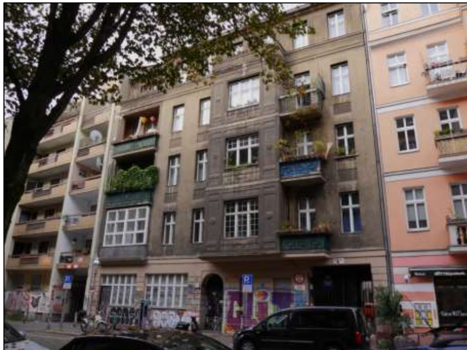
straßenseitige Front des Vorderhauses
