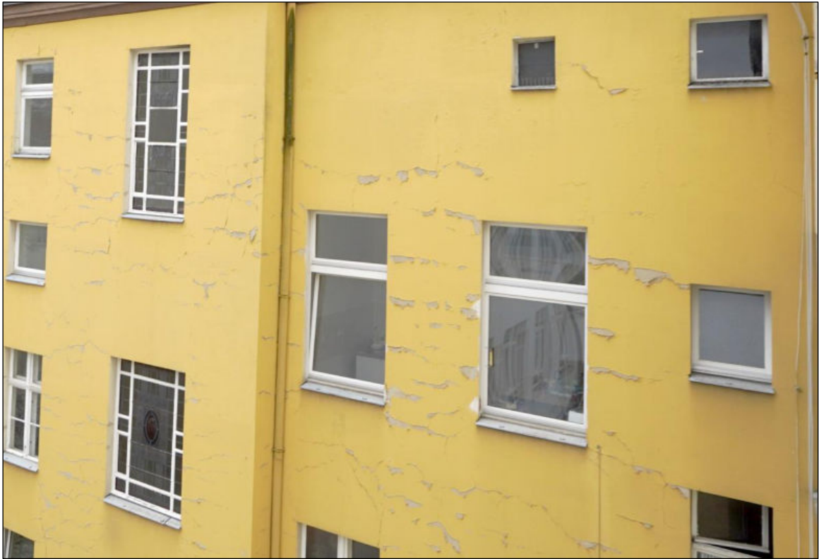
Farbschäden Fassade
