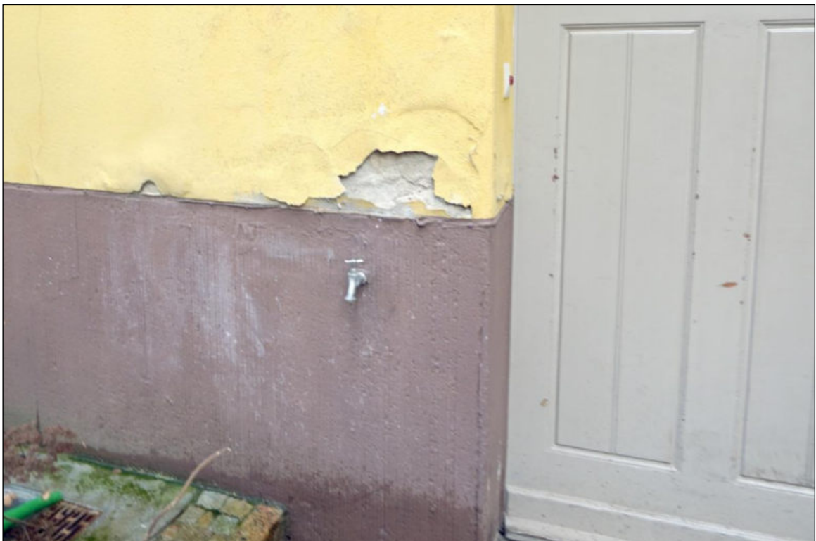
Putzschäden Sockel
