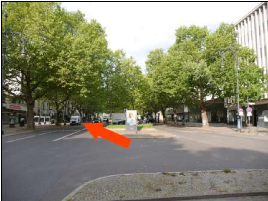
Blick in den Kurfürstendamm nach Westen mit Lage des auf der südlichen bzw. im Bild linken Straßenseite auf dem Grundstück Kurfürstendamm 132A aufstehenden Wohn- und Geschäftshauses (Pfeil)
