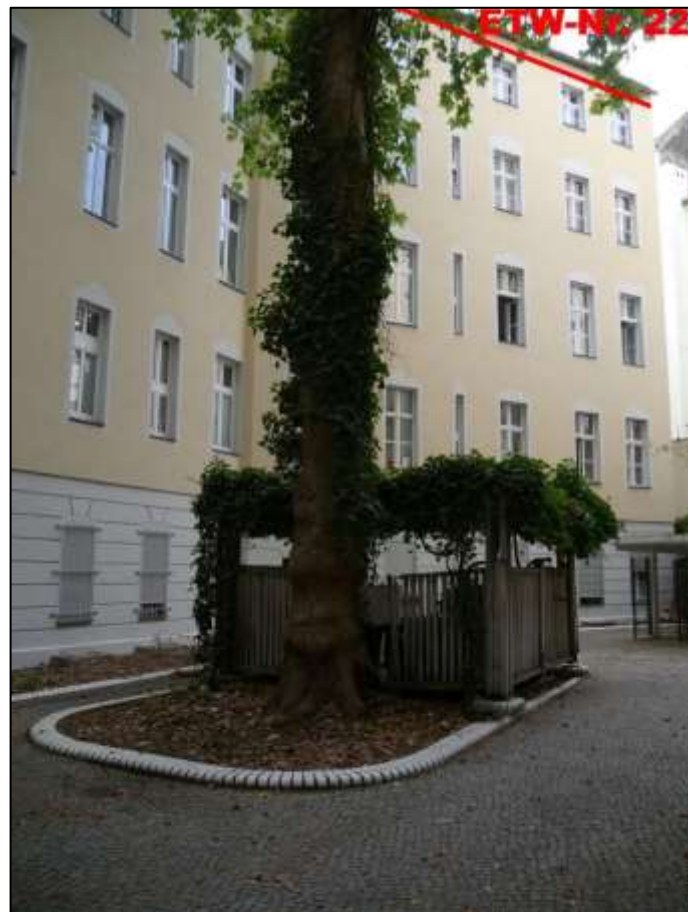
linker Seitenflügel mit Lage der ETW-Nr. 22 im 4. Obergeschoss
