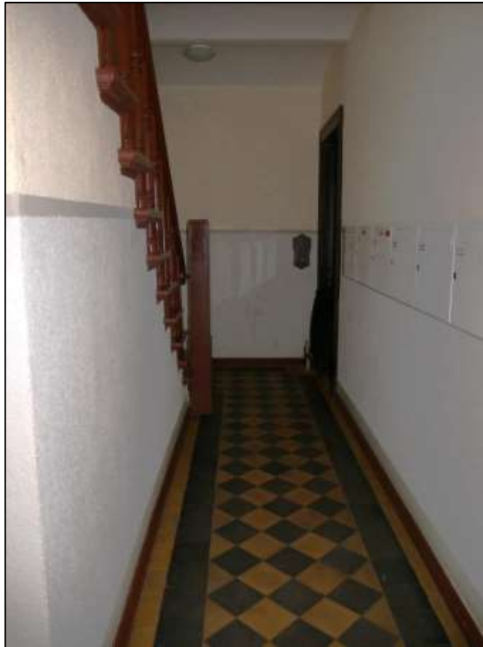
Hauseingangsbereich des linken Seitenflügels
