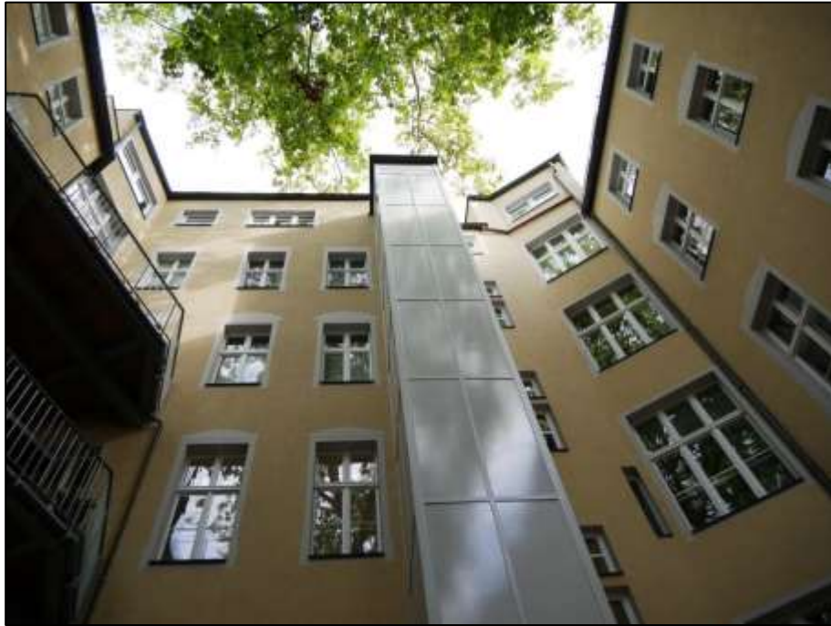
hofseitige Front des Vorderhauses mit Fassadenaufzug nebst anbindenden Seitenflügeln
