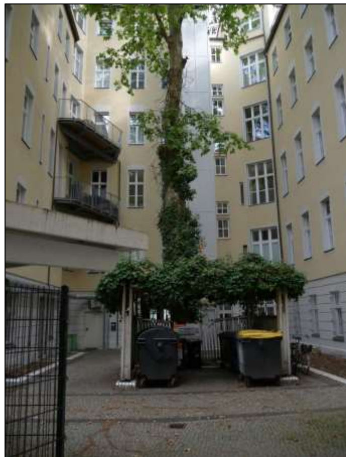
zentral im Hof belegener Müllgefäß-Stellplatz mit Vorderhaus im Hintergrund nebst rechts und links im Bild daran anbindende Seitenflügel
