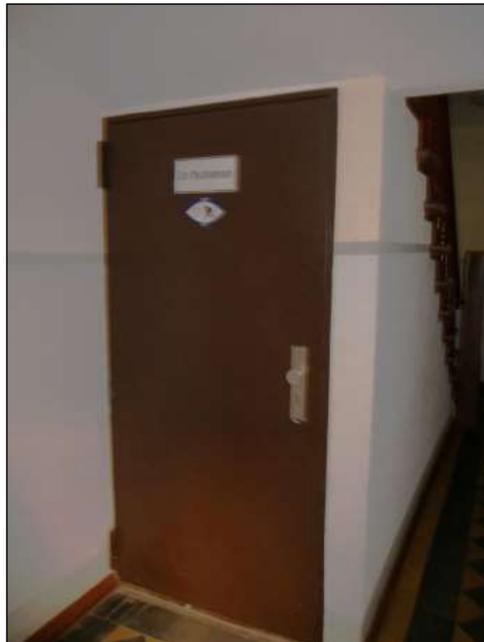
eingehauster Kellertreppenbergang im Hauseingangsbereich des linken Seitenflügels
