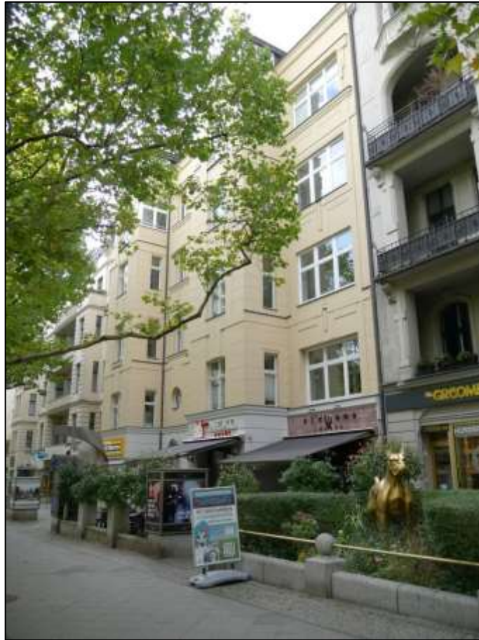
Straßenraum vor dem hier betroffenen Grundstück Kurfürstendamm 132A mit befestigter ehemaliger Vorgartenfläche (nunmehr öffentlicher Straßenraum) und Einfriedung der Schankgartenfläche des ansässigen Gastronomiebetriebes
