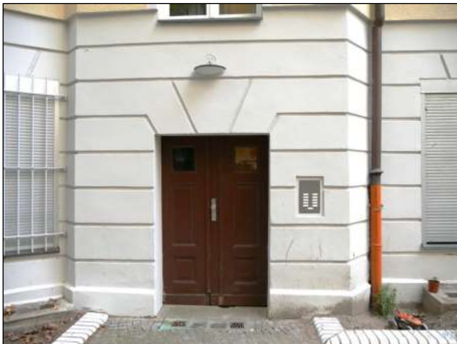
Hauseingangstür des linken Seitenflügels
