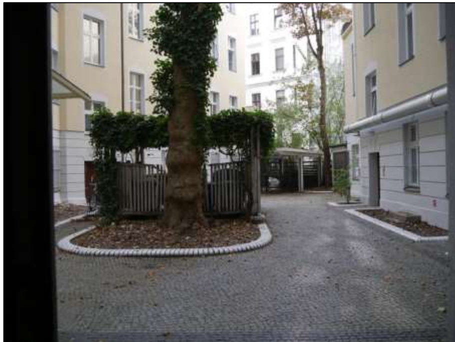
Blick aus der Vorderhausdurchfahrt bzw. -durchwegung in den Hof des Anwesens mit anbindendem rechtem Seitenflügel
