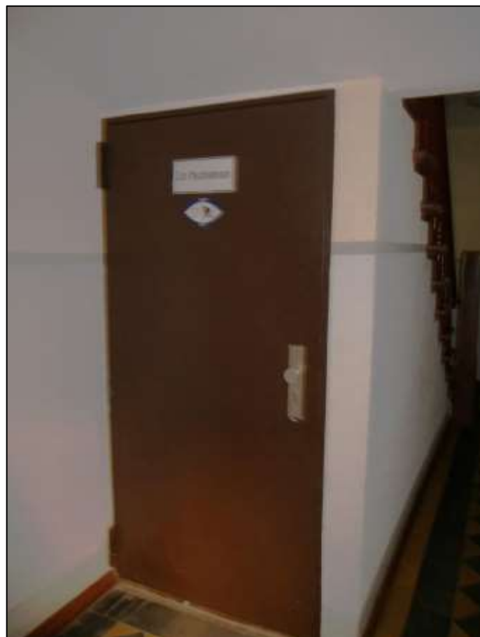
eingehauster Kellertreppenbergang im Hauseingangsbereich des linken Seitenflügels
