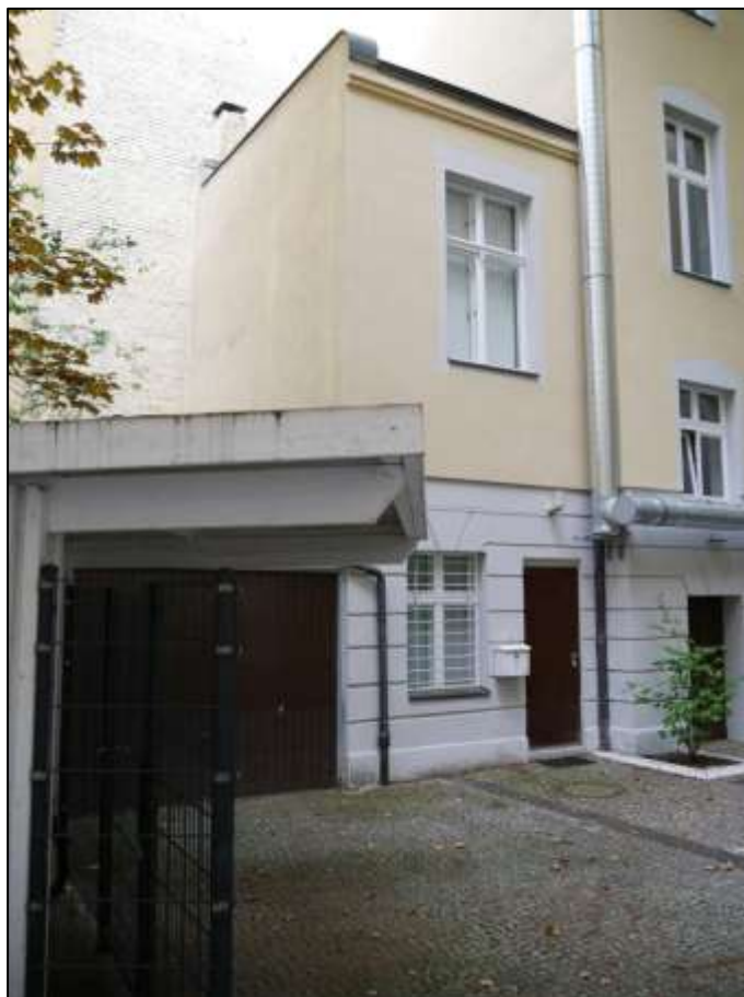
2-geschossiger Anbau an der freien Kopfseite des rechten Seitenflügels mit davor belegendem Garagenanbau
