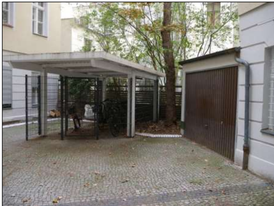
vor der rückwärtigen Grundstücksgrenze belegener Carport mit Stabmatteneinhausung und rechts daneben belegene Einzelgarage als Grenzgarage
