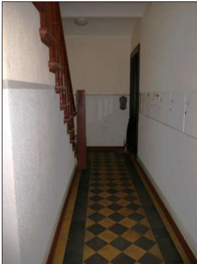
Hauseingangsbereich des linken Seitenflügels
