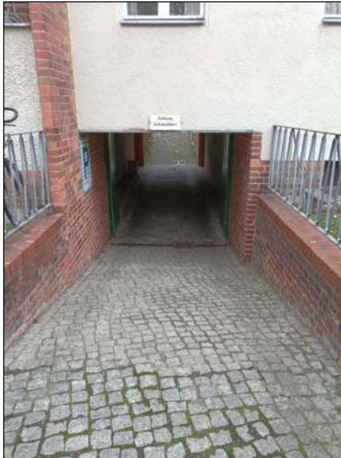
Zufahrt der Gebäudedurchfahrt von der Schlangenhader Straße aus im Kellergeschoss des Gebäudeteils Wiesbadener Str. 49
