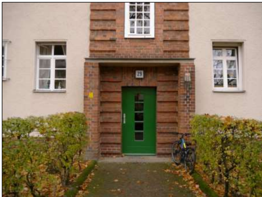
straßenseitige Hauseingangstür zum Treppenhaus des Gebäudeteils Eberbacher Str. 29
