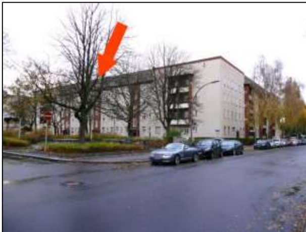
Blick aus der Schlangenbader Straße n. S-O
