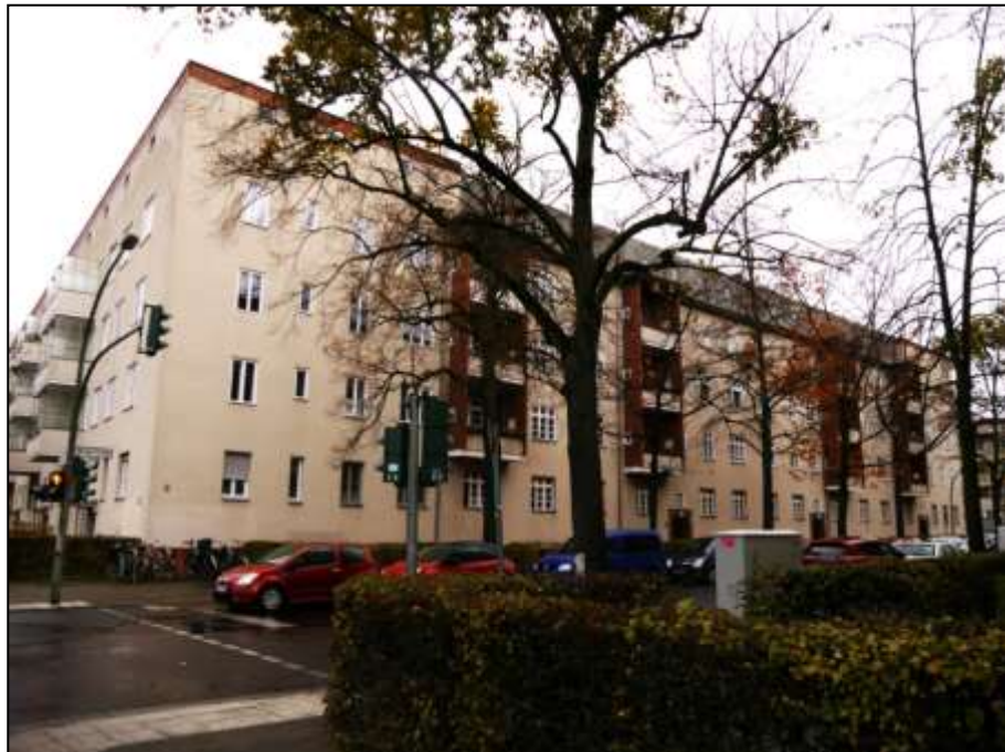
Blick aus der Wiesbadener Straße auf die zur Binger Straße orientierte Gebäudefront des auf dem Grundstück (Flurstück 21/21) aufstehenden Wohnkomplexes
