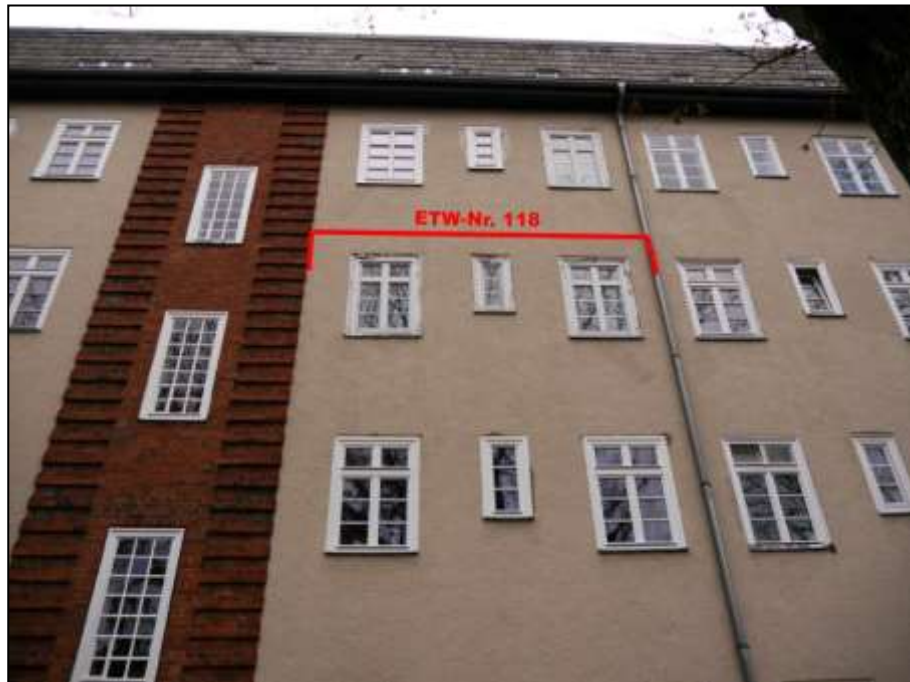
Gebäudeteil Eberbacher Str. 29 mit Lage des Wohnungseigentums Nr. 118 im 2. Obergeschoss (postalisch rechts im Treppenaufgang)
