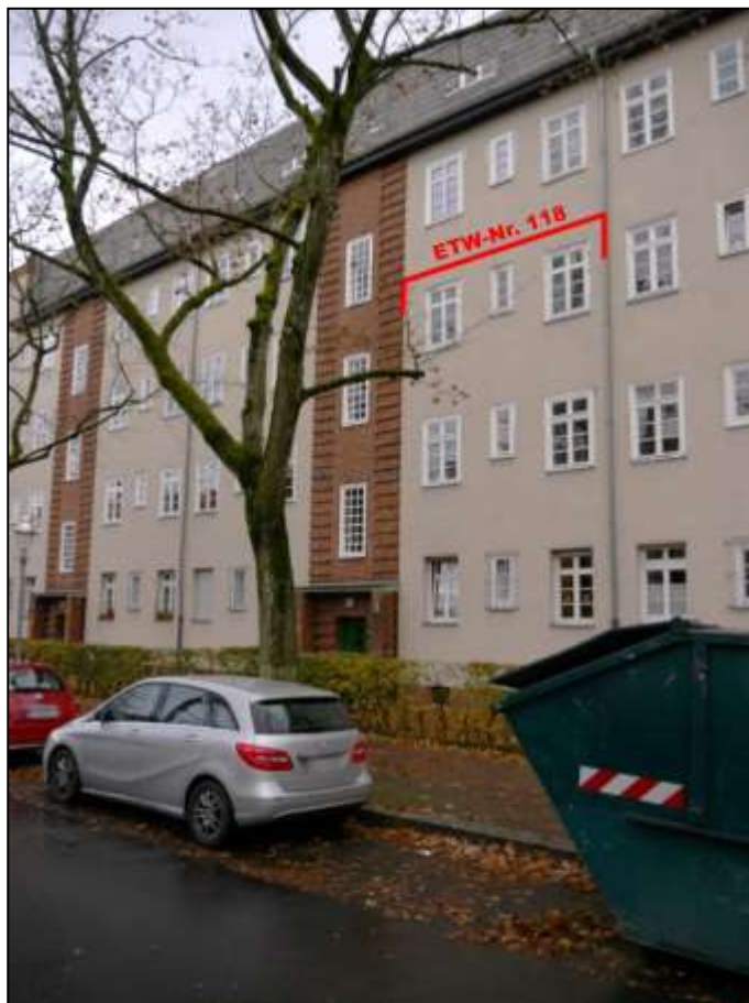
Gebäudeteil Eberbacher Str. 29 mit Lage des Wohnungseigentums Nr. 118 im 2. Obergeschoss (postalisch rechts im Treppenaufgang)
