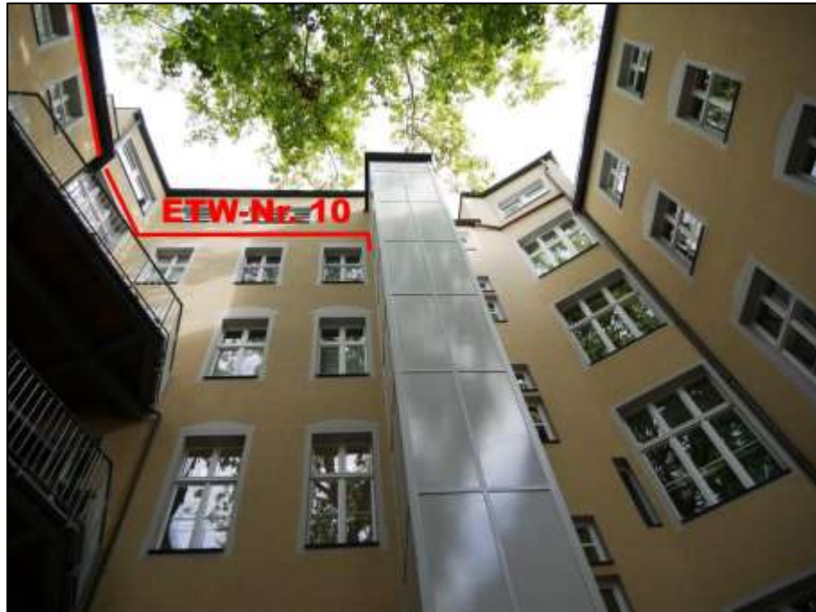
hofseitige Front des Vorderhauses mit Fassadenaufzug nebst anbindenden Seitenflügeln - ETW-Nr. 10 im 4. OG
