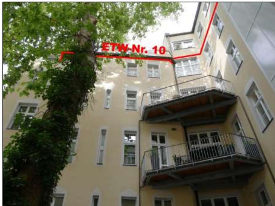
rechter Seitenflügel im Bereich der Obergeschosse mit rechts im Bild anbindendem Vorderhaus - ETW-Nr. 10 im 4. OG
