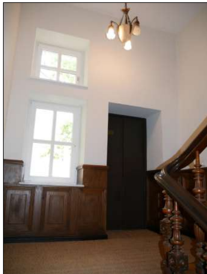
zwischen dem 1. und dem 2. Obergeschoss des Vorderhauses Kurfürstendamm 132A belegenes Zwischengeschosspodest mit anbindendem Fassadenaufzug
