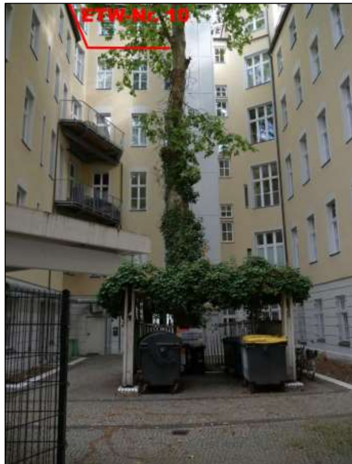
zentral im Hof belegener Müllgefäß-Stellplatz mit Vorderhaus im Hintergrund nebst rechts und links im Bild daran anbindende Seitenflügel - ETW-Nr. 10 im 4. OG
