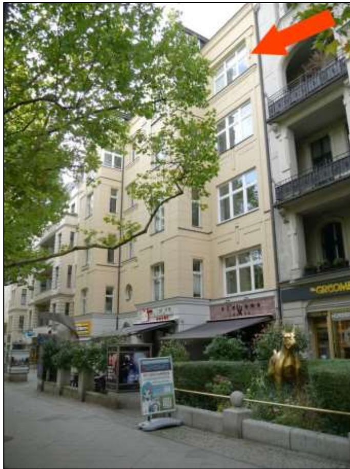
Straßenraum vor dem hier betroffenen Grundstück Kurfürstendamm 132A mit befestigter ehemaliger Vorgartenfläche (nunmehr öffentlicher Straßenraum) und Einfriedung der Schankgartenfläche des ansässigen Gastronomiebetriebes - ETW-Nr. 10 im 4. OG (Pfeil)
