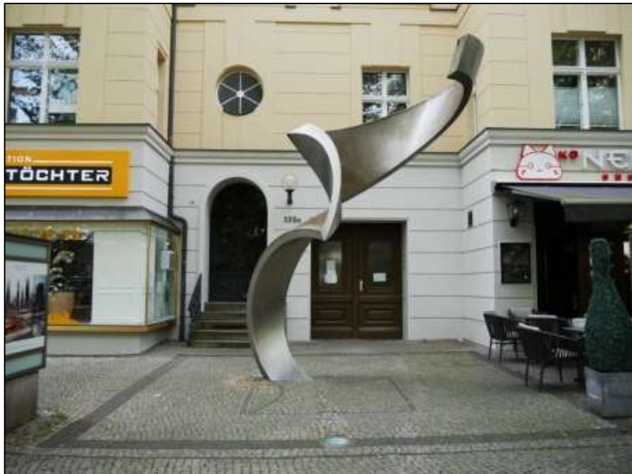
Vorderhauseingang zum Treppenhaus und Gebäudedurchfahrt bzw. -durchwegung zu dem Hof des Anwesens auf dem Grundstück Kurfürstendamm 132A - im Vordergrund Edelstahl-Skulptur im Bereich der ehemaligen Vorgartenfläche
