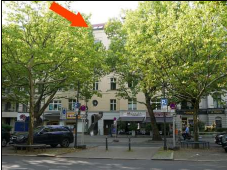
Blick über den Kurfürstendamm nach Süd-Osten mit Lage des auf der südlichen Straßenseite auf dem Grundstück Kurfürstendamm 132A aufstehenden Wohn- und Geschäftshauses (Pfeil)
