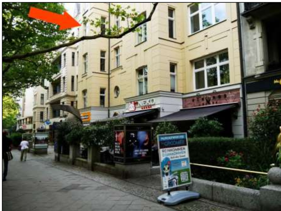
Straßenraum vor dem hier betroffenen Grundstück Kurfürstendamm 132A mit befestigter ehemaliger Vorgartenfläche (nunmehr öffentlicher Straßenraum) und Einfriedung der Schankgartenfläche des ansässigen Gastronomiebetriebes - ETW-Nr. 7 im 3. OG (Pfeil)
