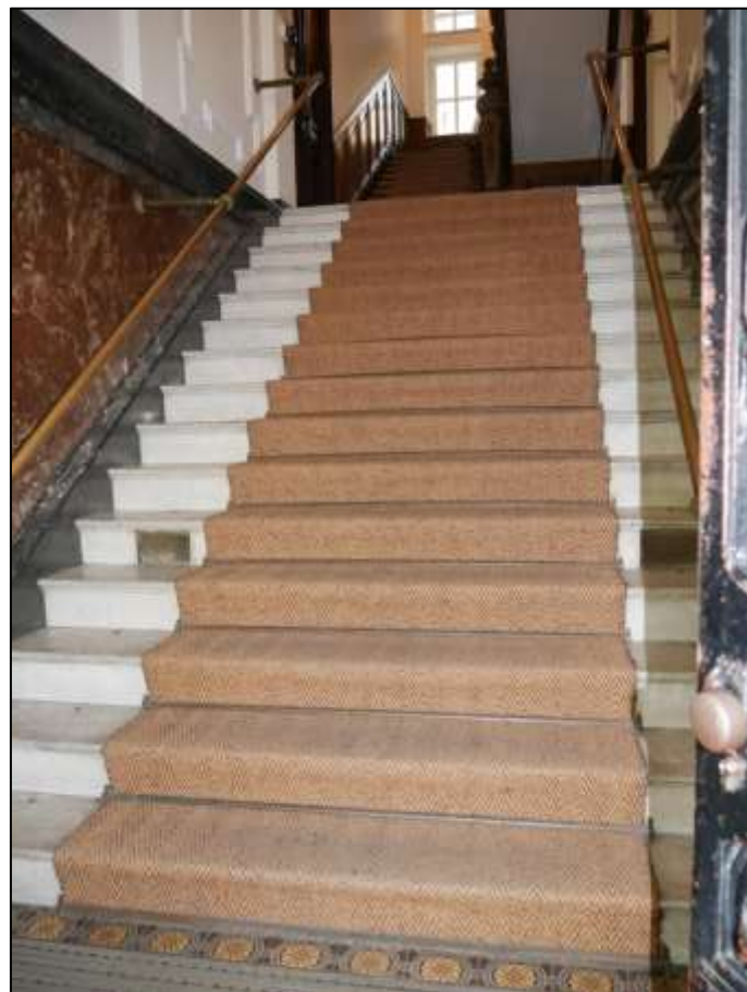
Hauseingangs- bereich des Vorderhauses Kurfürsten- damm 132A mit zum 1. Ober- geschoss auf- gehender Trep- pe
