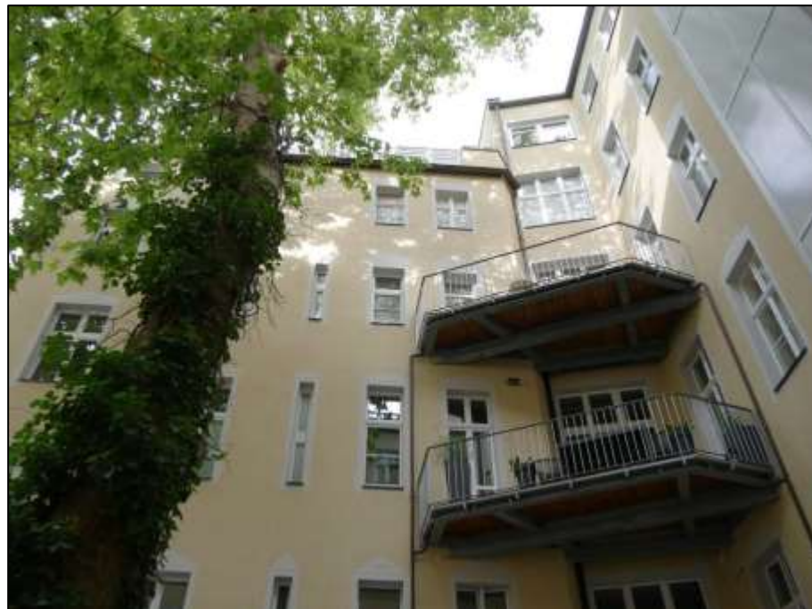
rechter Seitenflügel im Bereich der Obergeschosse mit rechts im Bild anbindendem Vorderhaus
