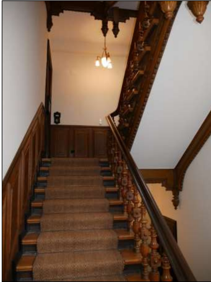
aufgehendes Treppenhaus im Vorderhaus Kurfürsten- damm 132A
