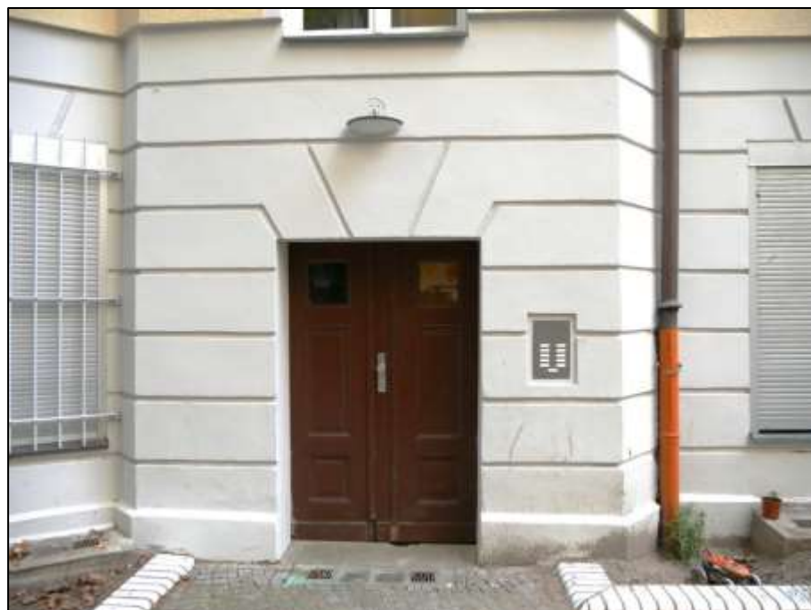
Hauseingangstür des linken Seitenflügels
