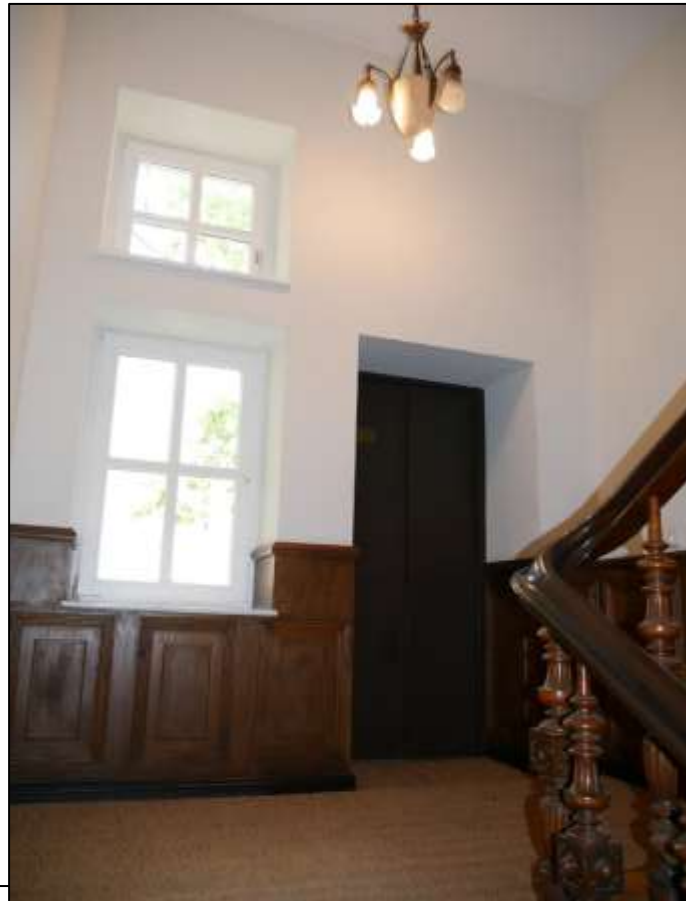
zwischen dem 1. und dem 2. Obergeschoss des Vorderhaus- es Kurfürsten- damm 132A belegenes Zwischenge- schoss-podest mit anbinden- dem Fassaden- aufzug
