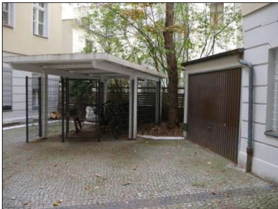
vor der rückwärtigen Grundstücksgrenze belegener Carport mit Stabmatteneinhausung und rechts daneben belegene Einzelgarage als Grenzgarage
