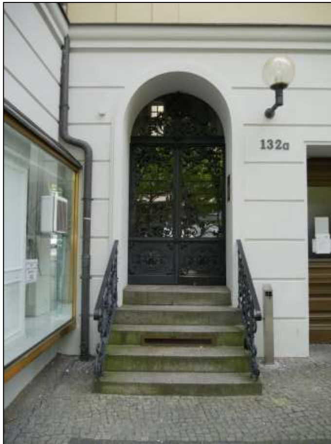
straßenseitiger Hauseingang des Vorderhau- ses Kurfürsten- damm 132A
