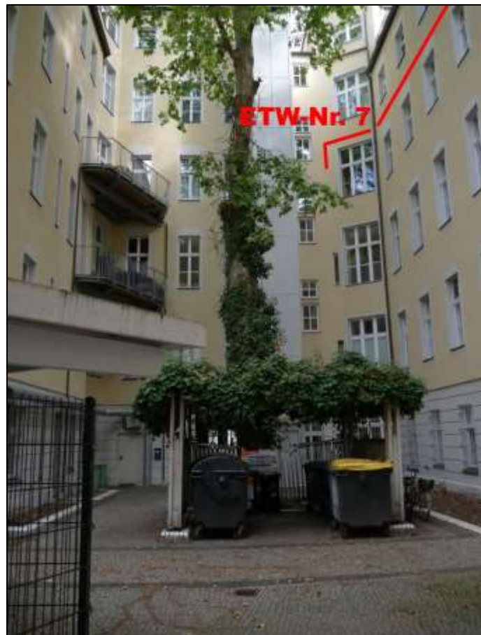
zentral im Hof belegener Müllgefäß-Stellplatz mit Vorderhaus im Hintergrund nebst rechts und links im Bild daran anbindende Seitenflügel - ETW-Nr. 7 im 3. OG
