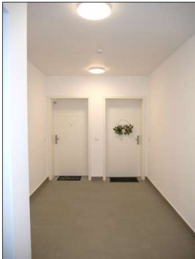
Treppenhausflur im 5. Obergeschoss (untere Dachgeschossesebene) mit rechts im Bild anbindender Eingangstür des Wohnungseigentums Nr. C.5.2
