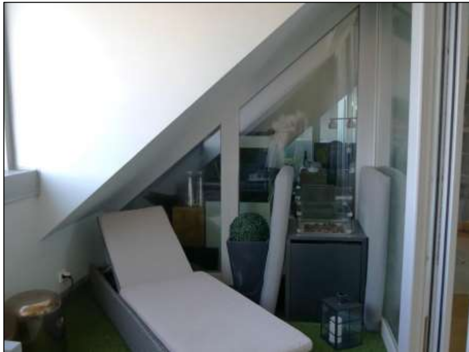
Gaubenloggia im Wohnungseigentum Nr. C.5.2 mit rechter Backe zum angrenzenden Wohn-/Esszimmer
