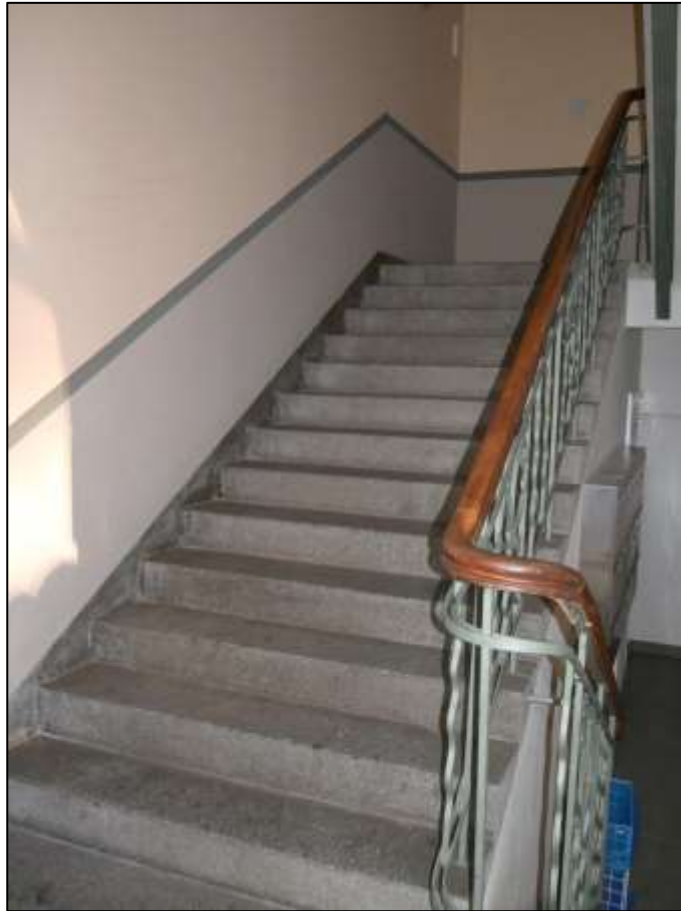
Hauseingangsbereich des Gebäudeteils Mollwitzstr. 13 mit aufgehender Treppe in das 1. Obergeschoss
