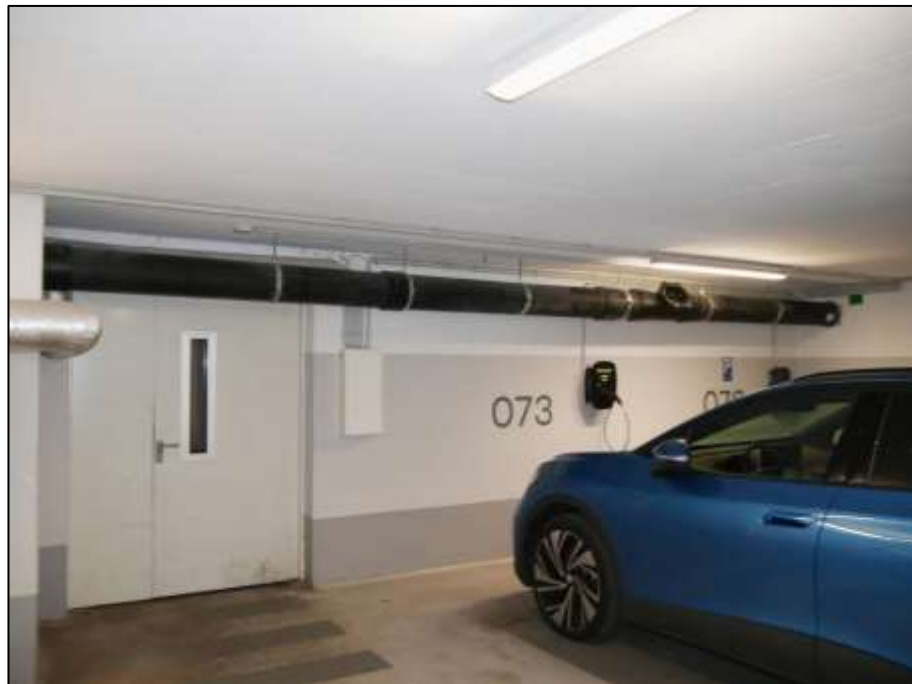
Tiefgarage auf dem Nachbargrundstück Mollwitzstr. 11, 12 (Flurstück 1235) im Bereich der Gebäudeteile Mollwitzstraße 12 und Sophie-Charlotten-Str. 115B bzw. dem angrenzenden Grundstück Sophie-Charlotten-Str. 117 (Flurstück 1260) mit Zugang zum Müllgefäß-Stellplatzraum
