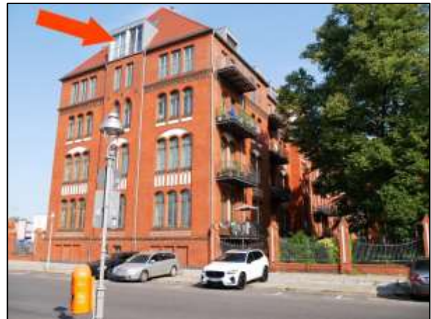
Gebäudeteil Mollwitzstr. 13 - WE-Nr. C.5.2
