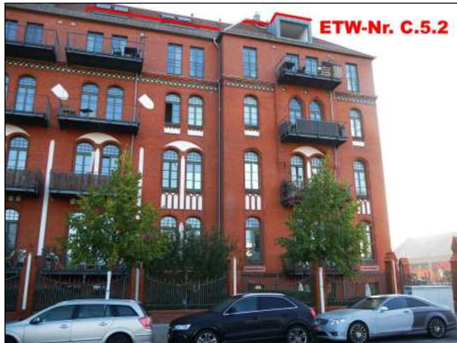
Blick über die Sophie-Charlotten-Straße nach Osten auf die straßenseitige Front des Gebäudeteils Mollwitzstr. 13 mit Lage des Wohnungseigentums Nr. C.5.2 im 5.OG (DG) mit Kastengaubenloggia nebst darüber belegenen liegenden Fenstern und links davon zwei Dachflächenloggias
