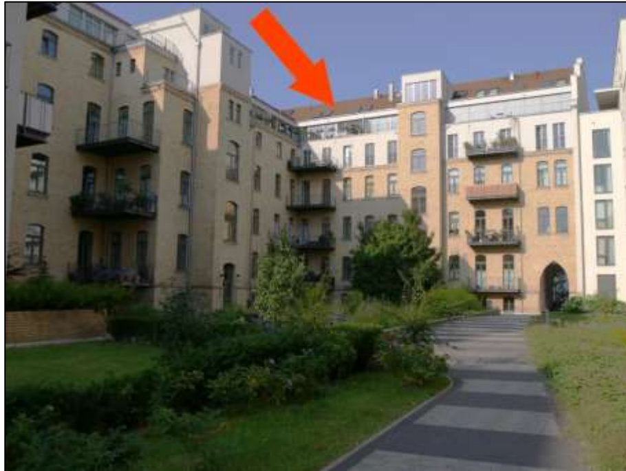
Blick aus dem Blockinnenbereich auf die östliche Front des Gebäude- teils Sophie-Charlotten-Str. 115A (Pfeil) u.a. mit Gebäudedurchfahrt von der Sophie-Charlotten-Straße aus auf dem Grundstück Sophie- Charlotten-Straße 115, 115A, Mollwitzstr. 13 (Flurstück 1234) - links im Bild anbindende Gebäudeteile des früheren Krankenhauskomple- xes auf dem Grundstück Mollwitzstraße 11, 12, u.a. (Flurstück 1235)
