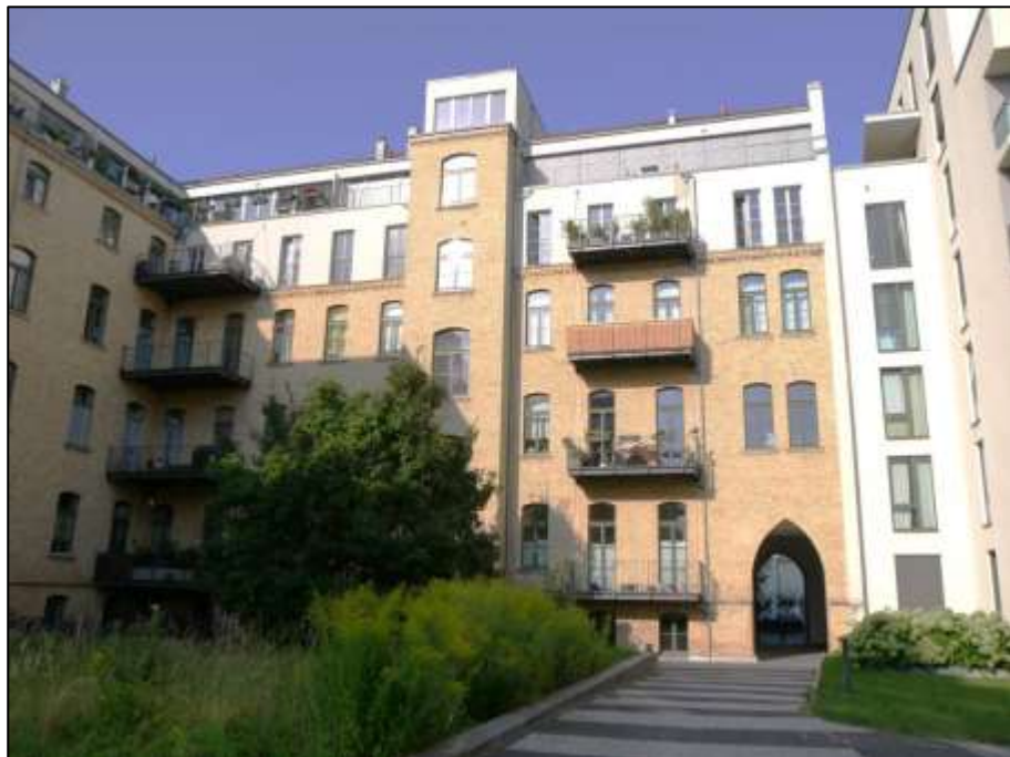
Blick aus dem Blockinnenbereich auf die östliche Front des Gebäudeteils Sophie-Charlotten-Str. 115A u.a. mit Gebäudedurchfahrt von der Sophie-Charlotten-Straße aus auf dem Grundstück Sophie-Charlotten-Straße 115, 115A, Mollwitzstr. 13
