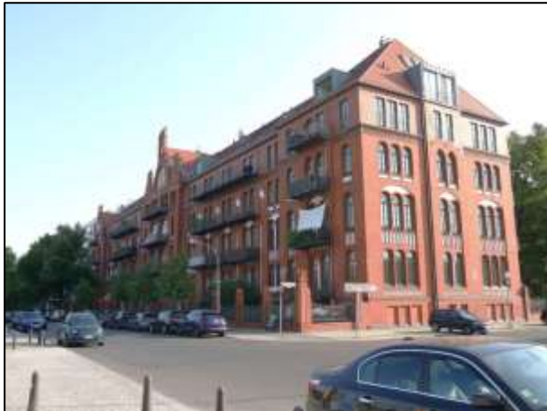
Grundstück Sophie-Charlotten-Str. 115 u.a.
