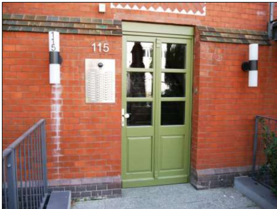
zur Sophie-Charlotten-Straße orientierter Hauseingang des Gebäudeteils Sophie-Charlotten-Str. 115
