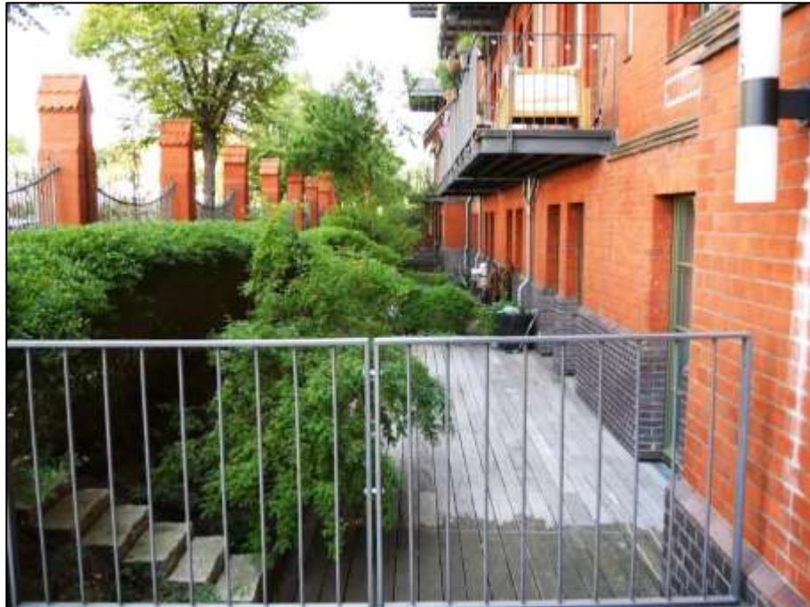
Blick aus dem Bereich vor dem Hauseingang des Gebäudeteils Sophie-Charlotten-Str. 115 in den vor der straßenseitigen Gebäudefront belegenen Terrassengraben der im Untergeschoss bzw. sogen. Gartengeschoss belegenen Apartments
