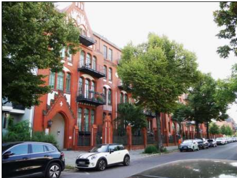
Blick aus der Sophie-Charlotten-Straße auf die auf dem Grundstück Sophie-Charlotten-Str. 115, 115A, Mollwitzstr. 13 aufstehende Bebauung mit Gebäudedurchfahrt in den Blockinnenbereich im Gebäudeteil Sophie-Charlotten-Str. 115A links im Bild
