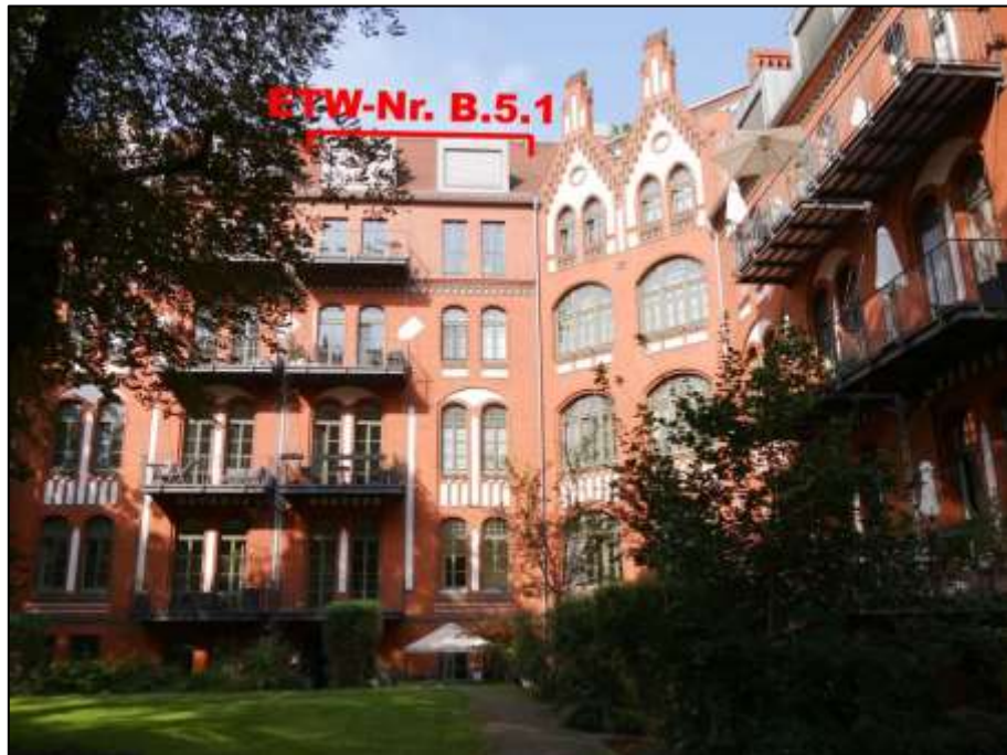
Blick aus dem Gartengrundstück Mollwitzstr. 11, 12, 13 u.a. (Flurstück 1239) auf die östliche Front des Gebäudeteils Sophie-Charlotten-Str. 115 mit Lage der ETW-Nr. B.5.1 im 5.OG (DG) auf dem Grundstück Sophie-Charlotten-Str. 115, 115A, Mollwitzstr. 13 (Flurstück 1234)
