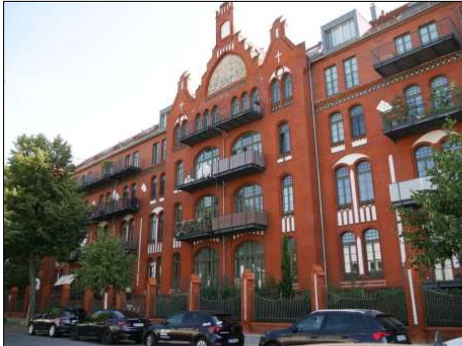
Blick aus der Sophie-Charlotten-Straße auf die nach Westen orientierte Gebäudefront des Komplexes im Bereich des Gebäudeteils Sophie-Charlotten-Str. 115
