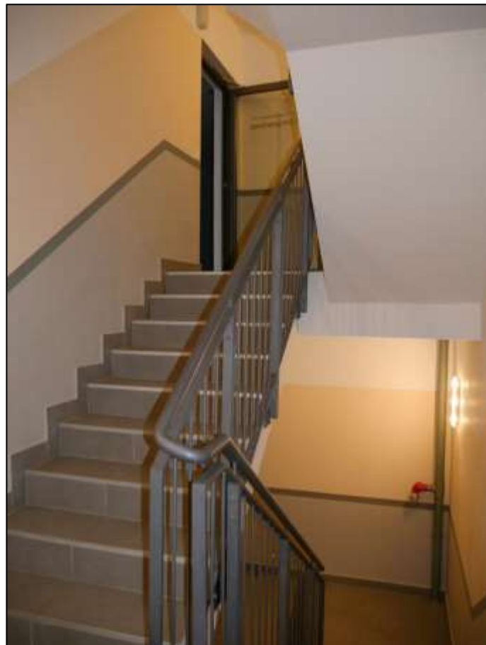
Treppenhaus im Gebäudeteil Sophie-Charlotten-Str. 115 mit Blick von dem Zwischengeschosspodest zwischen 4.OG und 5.OG auf den Zugang des an das Treppenhaus anbindenden Flurs im 5.OG (DG)
