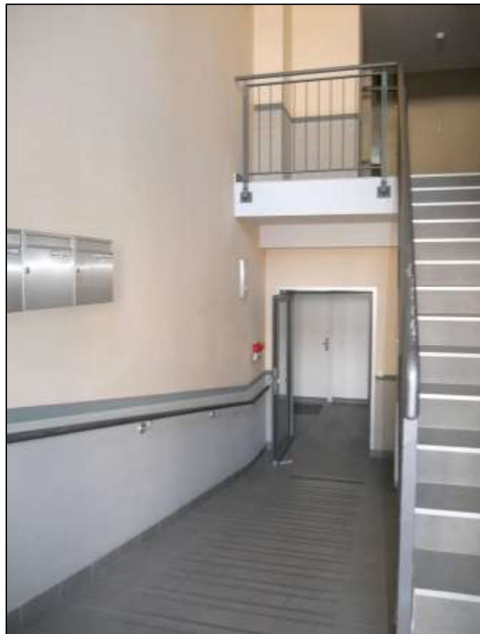
Hauseingangsbereich im Gebäudeteil Sophie-Charlotten-Str. 115 mit in das Untergeschoss bzw. sogen. Gartengeschoss) abgehender Rampe
