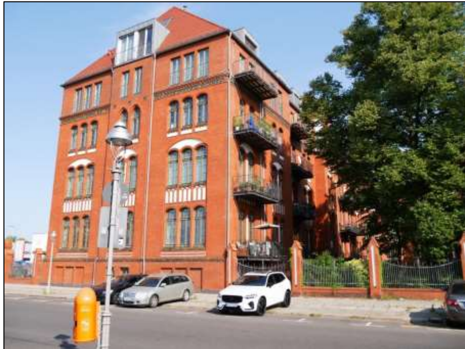
Blick aus der Mollwitzstraße auf die südliche Giebelseite des Gebäudeteils Mollwitzstr. 13 des auf dem Grundstück Sophie-Charlotten-Str. 115, 115A, Mollwitzstr. 13 (Flurstück 1234) aufstehenden Gebäudekomplexes
