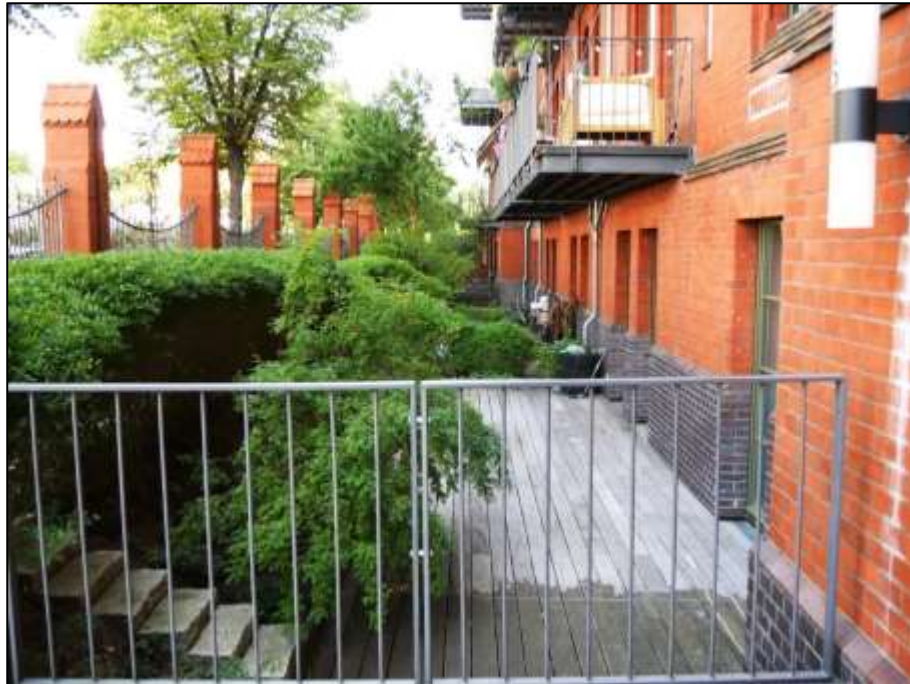
Blick aus dem Bereich vor dem Hauseingang des Gebäudeteils Sophie-Charlotten-Str. 115 in den vor der straßenseitigen Gebäudefront belegenen Terrassengraben der im Untergeschoss bzw. sogen. Gartengeschoss belegenen Apartments
