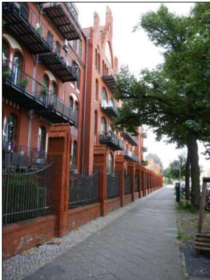
Blick aus der Sophie-Charlotten-Straße auf die nach Westen orientierte Gebäudefront des Komplexes mit davor belegenem Vorgartenbereich nebst darin belegenen Gartenterassen der im Untergeschoss belegenen Nutzungseinheiten und die massive Grundstückseinfriedung noch aus dem historischen Bestand
