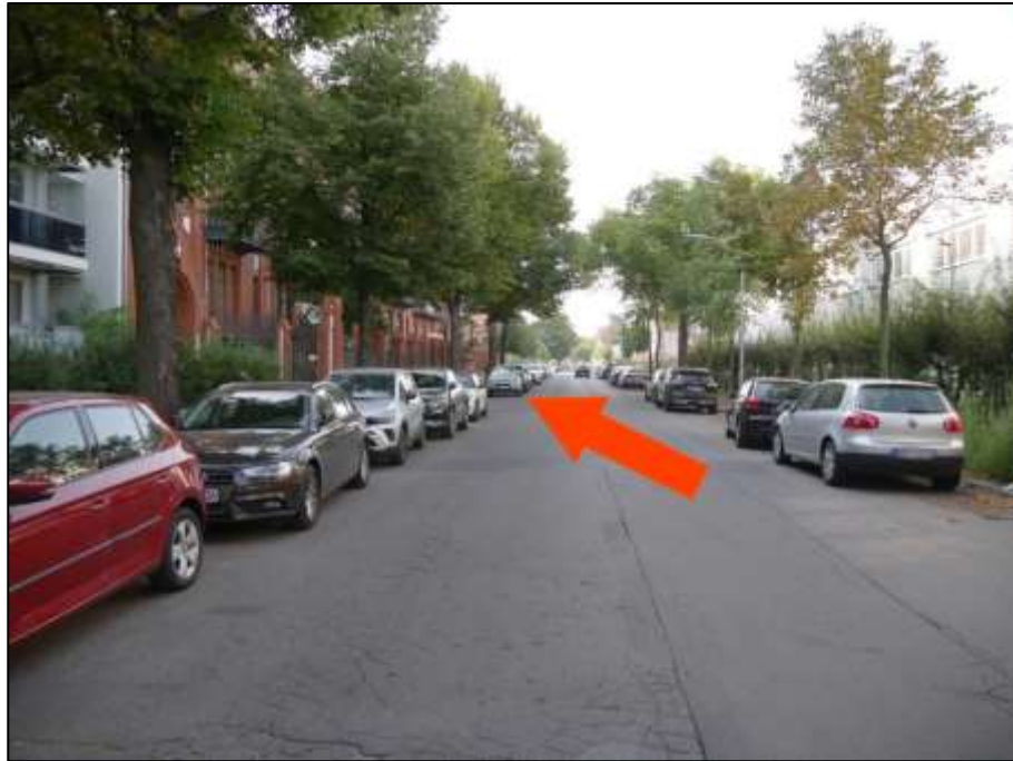
Blick in die Sophie-Charlotten-Straße nach Süden mit Lage des Grundstücks Sophie-Charlotten-Str. 115, 115A, Mollwitzstr. 13 auf der östlichen bzw. im Bild linken Straßenseite (Pfeil)
