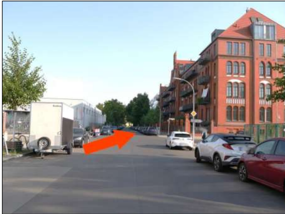
Blick in die Sophie-Charlotten-Straße nach Norden mit Lage des Grundstücks Sophie-Charlotten-Str. 115, 115A, Mollwitzstr. 13 auf der östlichen bzw. im Bild rechten Straßenseite (Pfeil) - im Vordergrund rechts einmündende Mollwitzstraße
