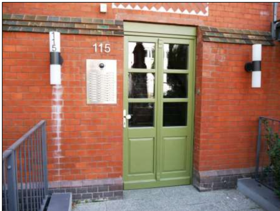
zur Sophie-Charlotten-Straße orientierter Hauseingang des Gebäudeteils Sophie-Charlotten-Str. 115
