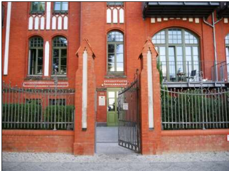
Blick aus dem Straßenraum der Sophie-Charlotten-Straße auf die straßenseitige Einfriedung mit Stahlgitterpforte zur Hauseingangszuwegung des Gebäudeteils-Sophie-Charlotten-Str. 115 mit anbindendem Treppenhauseingang
