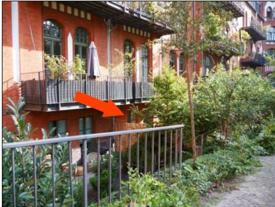
Gebäudeteil Mollwitzstr. 11 mit im Untergeschoss belegenem Teileigentum Nr. F.0.4 (Pfeil) im Gebäudekomplex auf dem Grundstück Mollwitzstraße 11, 12 in Hinterliegerlage (Flurstück 1235)
