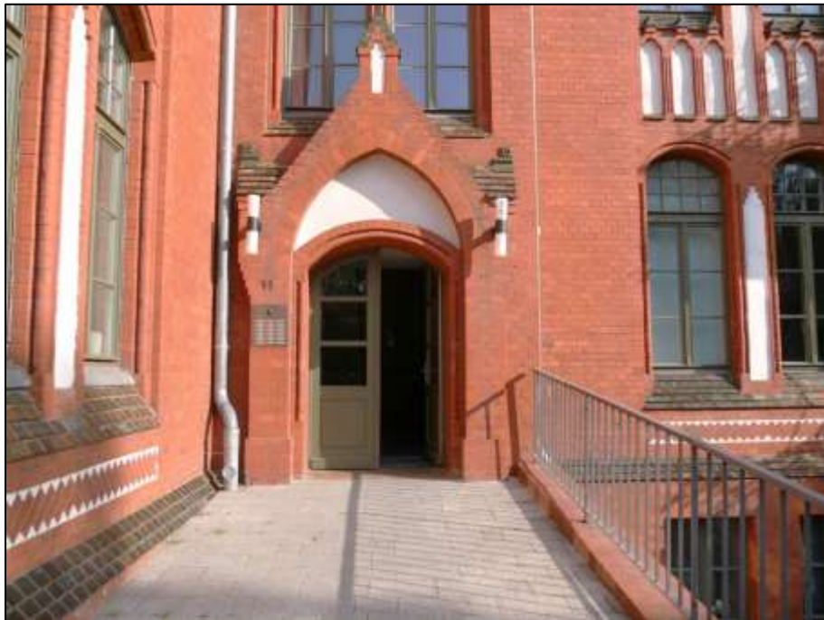
Treppeneingang des Gebäudeteils Mollwitzstr. 11 auf dem Grundstück Mollwitzstr. 11, 12 (Flurstück 1235)
