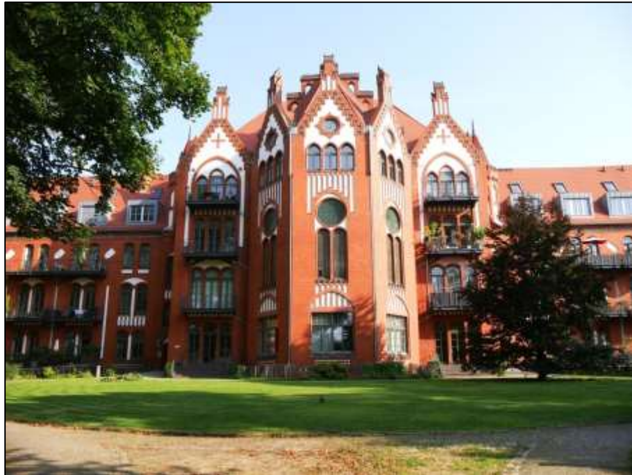
Blick durch den Torzugang in der straßenseitigen Einfriedung des Grundstücks Mollwitzstr. 11, 12, 13 u.a. (Flurstück 1239) auf den auf dem in sogen. Hinterliegerlage belegenen Grundstück Mollwitzstraße 11, 12 (Flurstück 1235) aufstehenden Gebäudekomplex mit Gebäude- teil Mollwitzstr. 11 rechts im Bild
