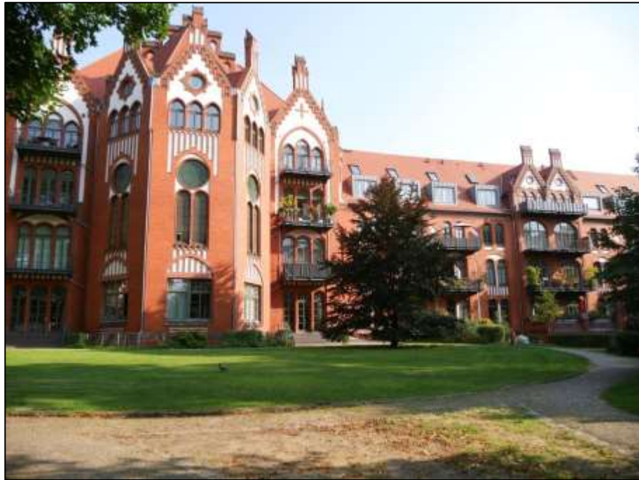
Blick über das Gemeinschaftsgrundstück Mollwitzstr. 11, 12, 13 u.a. (Flurstück 1239) auf den auf dem in sogen. Hinterliegerlage belegenen Grundstück Mollwitzstraße 11, 12 (Flurstück 1235) aufstehenden Gebäudekomplex mit Gebäudeteil Mollwitzstr. 11 rechts im Bild und daran rechts im Bild Gebäudeteil Heubnerweg 3A auf einem angrenzenden Nachbargrundstück
