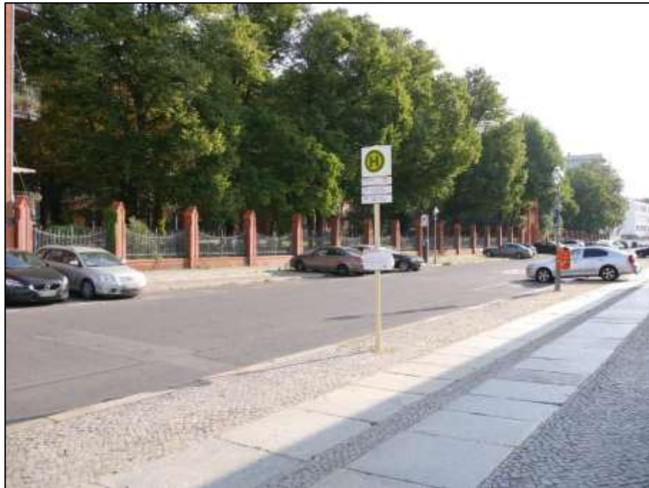
Blick über die Mollwitzstraße nach Nord-Osten auf die straßenseitige Front des Gemeinschaftsgrundstücks Mollwitzstr. 11, 12, 13 u.a. (Flurstück 1239) mit dahinter in sogen. Hinterliegerlage belegendem Grundstück Mollwitzstraße 11, 12 (Flurstück 1235)
