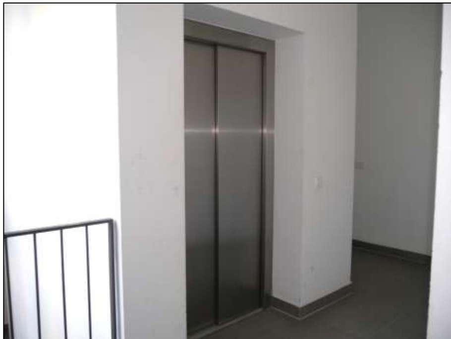
an den Treppenhausflur anbindende Aufzugsanlage im Gebäudeteil Mollwitzstr. 12
