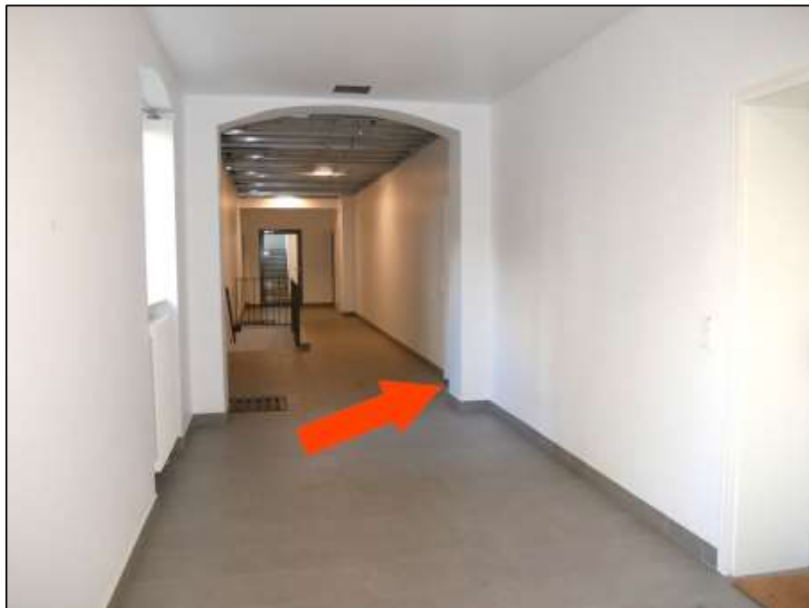
Treppenhausflur im Untergeschoss (Gartengeschoss) des Gebäudeteils Mollwitzstr. 12 mit Lage des Teileigentums Nr. E.01 (Pfeil)
