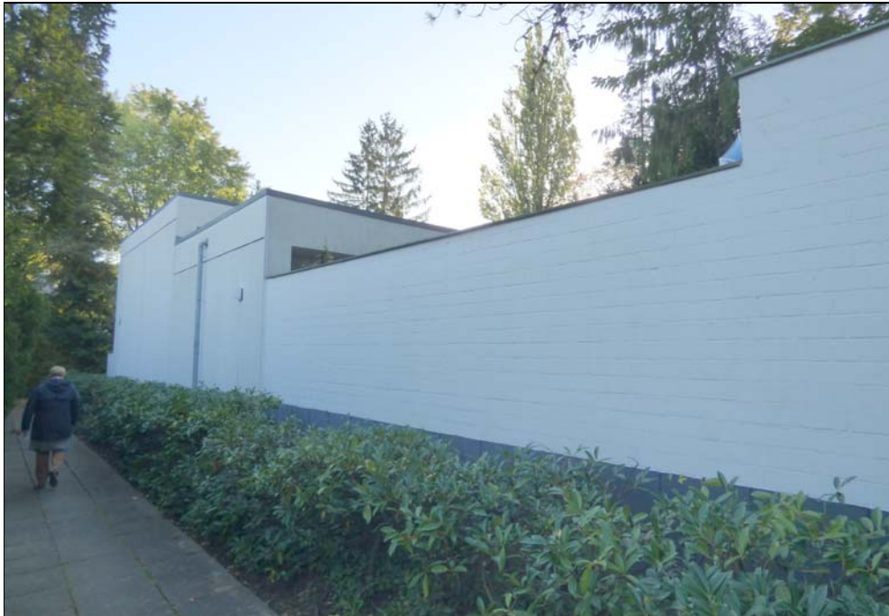
rückwärtige/seitliche Ansicht betreffende Eigentumseinheit Nr. 27 mit gemauerter Grundstücksabgrenzung zur zugeordneten Grundstücksfläche
