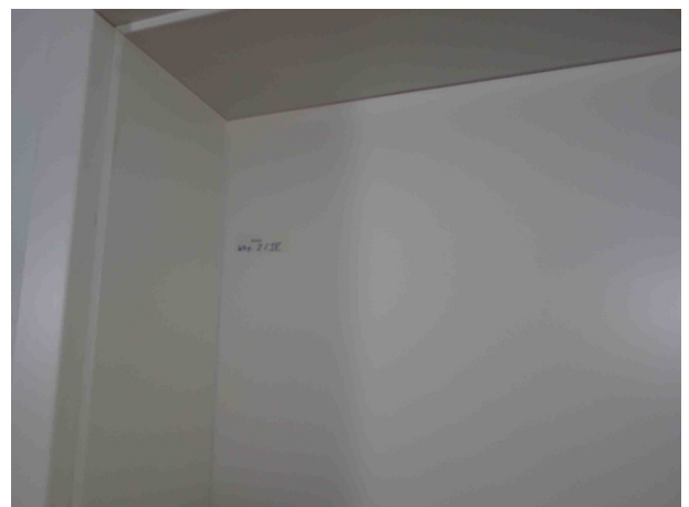
Abb. 42 Kellertür mit Wohnungsnummer IV/2
