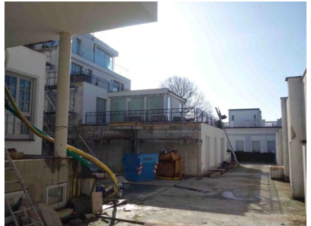
Abb. 14 Zugang zum Bauabschnitt IV
