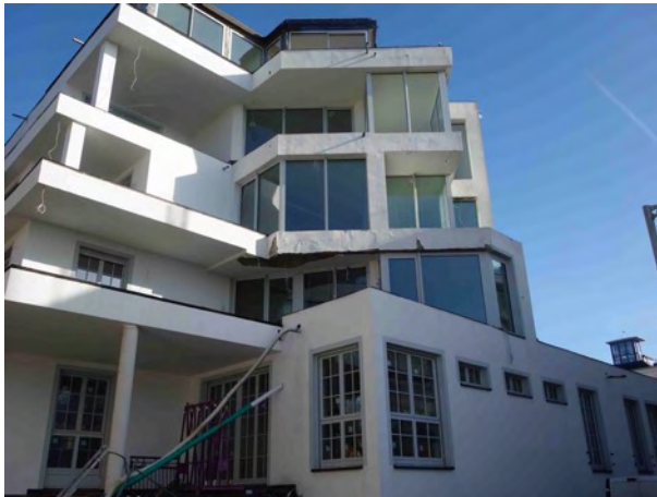
Abb. 21 Rückansicht des nicht fertiggestellten Bauabschnitts VI
