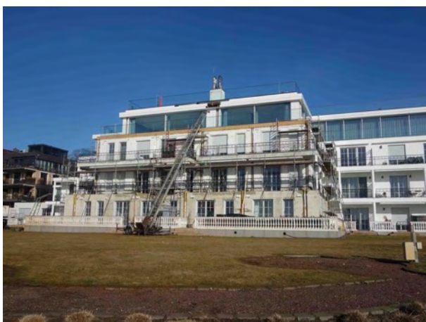
Abb. 17 Südfassade Bauabschnitt IV (Seeseite)
