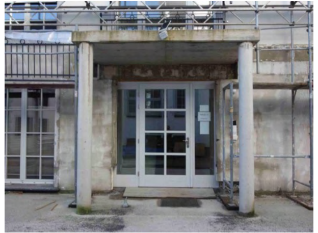
Abb. 20 Hauseingang Bauabschnitt IV
