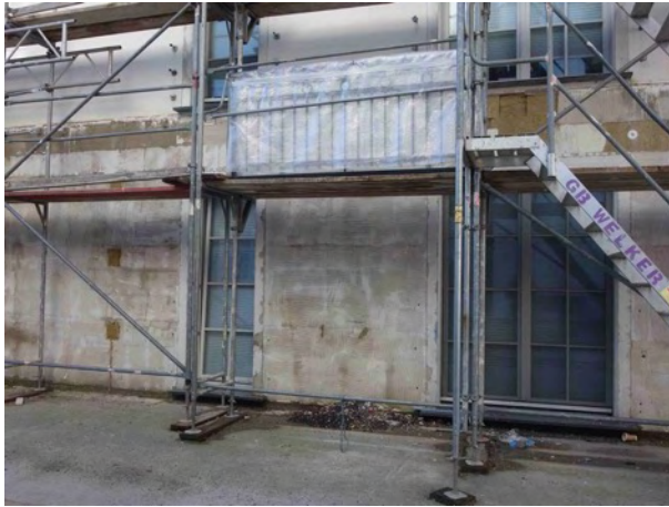
Abb. 19 Schlafzimmerfenster, Fenster Ankleidezimmer der Wohnung IV/2
