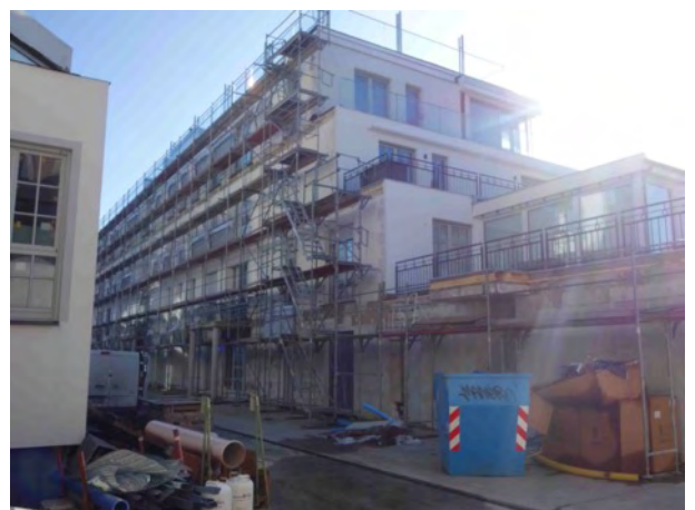
Abb. 18 Nordfassade Bauabschnitt IV
