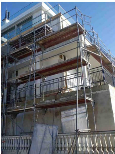
Abb. 23 Fassade Bauabschnitt IV mit geöffneten Installationsschächten
